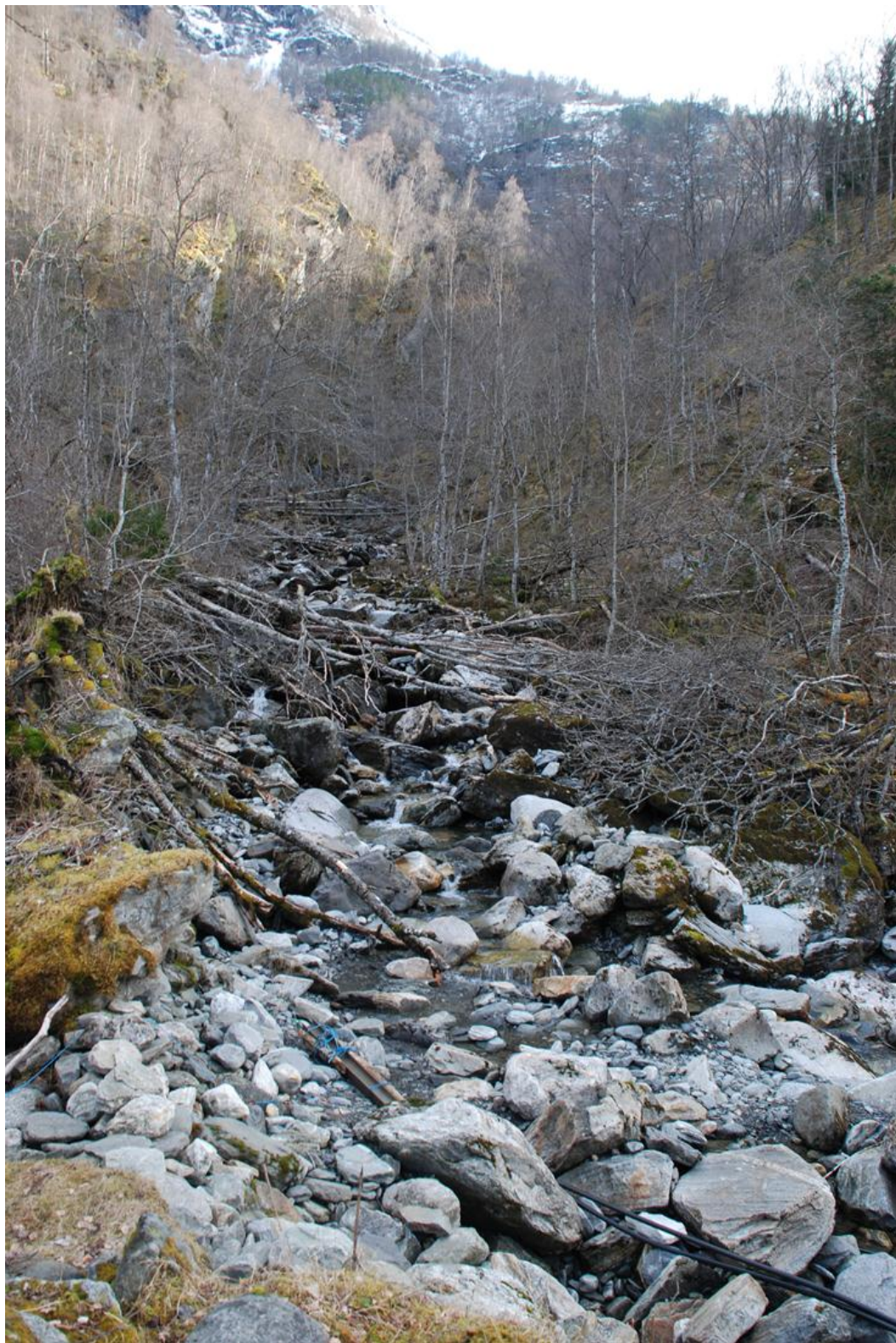
Bilde 2: Elven sett fra stedet der elven svinger utover fjorden. Hvis kraftstasjonen flyttes litt oppover langs elven kan vannet ledes tilbake i elven her. Her i elvesvingen trengs det forsterking av elvebredden.
