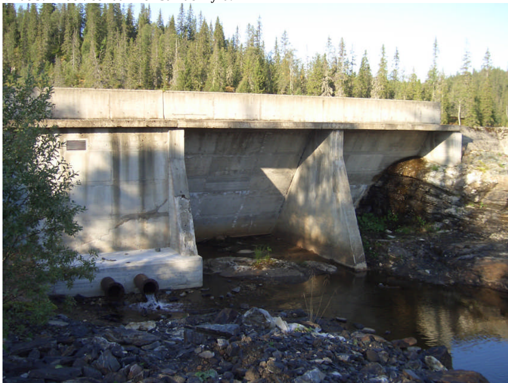
Bilde 6: Bilde viser dam for Samuelmyra.
