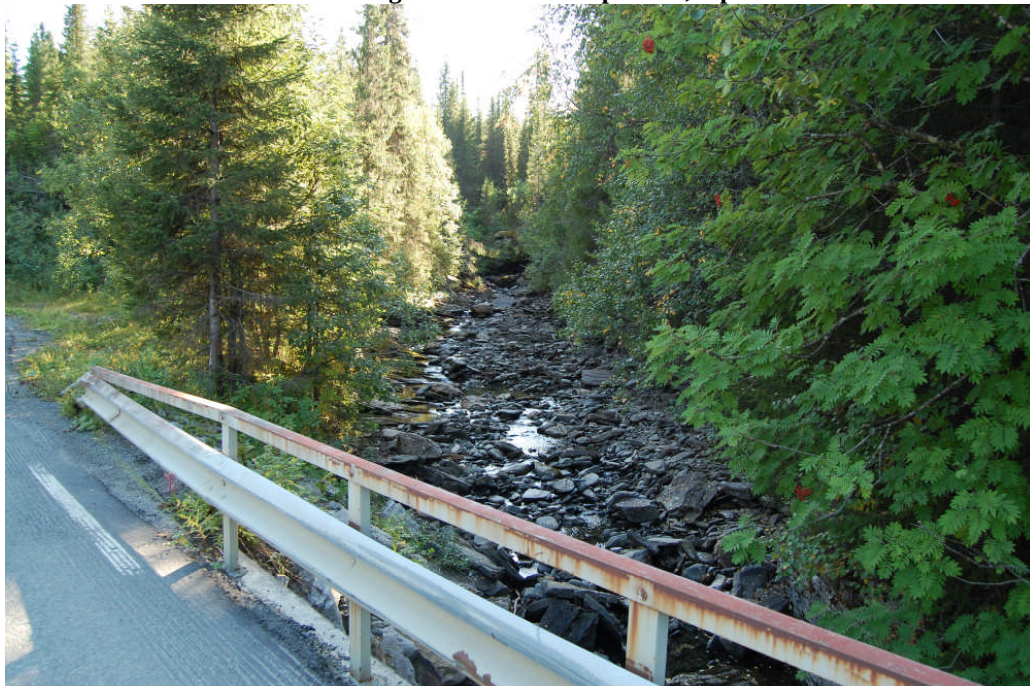
Bilde 6: Bilde av der Valåga krysser fylkesvei 321. Bilde tatt i tørr periode, september.2008.
