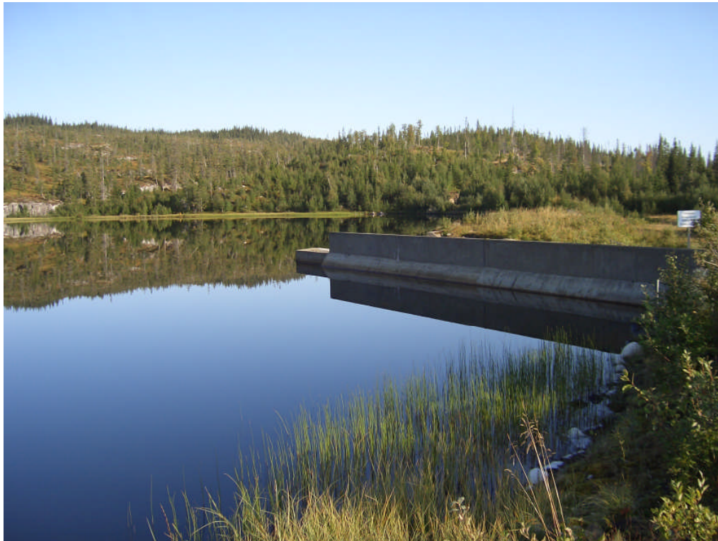
Bilde 5: Bilde viser dam for Samuelmyra.
