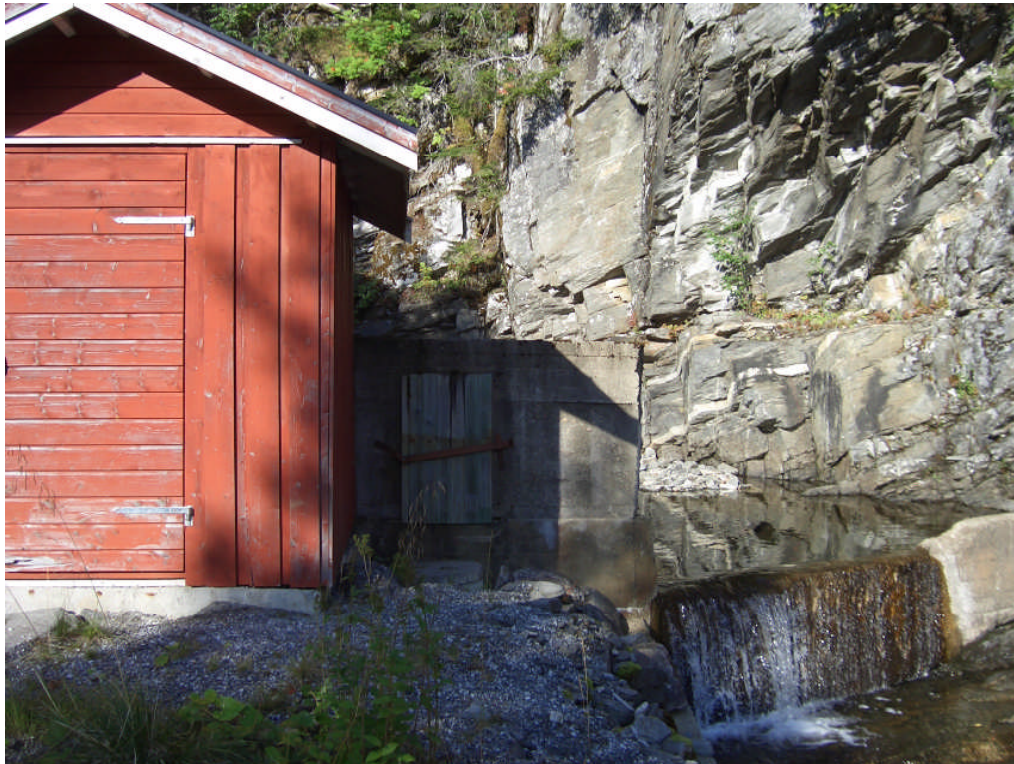
Bilde 3: Bilde av inntaket til Korgen vannverk.
