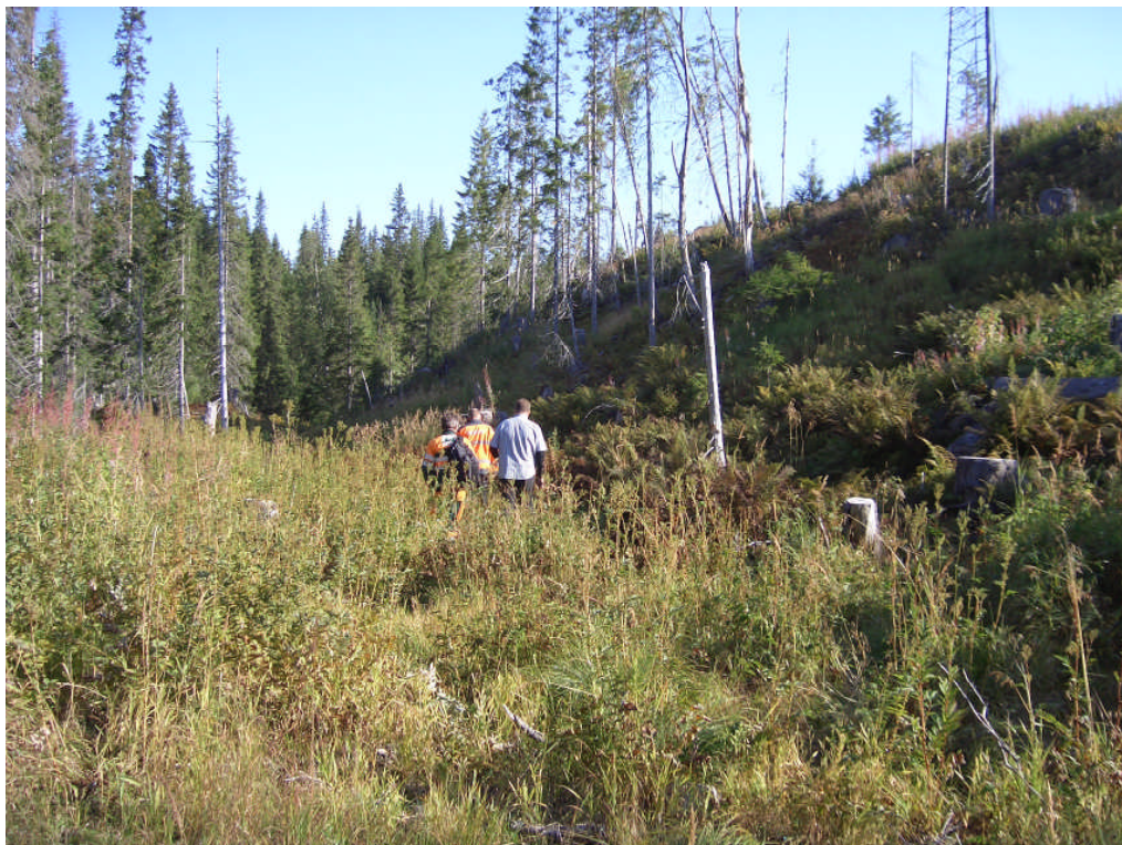
Bilde 8: Bilde over midtre del av planlagt rørtrase.
