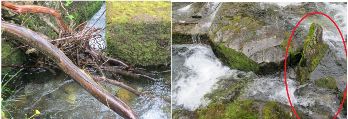
Figur 20. Her ser ein nærbilete av spesielt to stadar der laksetroppa er meir eller mindre sperra. Det eine biletet viser kvist og greiner som danner hinder for oppgang av fisk og det andre viser stein som har lagt seg i innløpet og hindrar vatn i å renne inn i troppa. (Foto: Oddvar Olsen © 16.08.2012).
