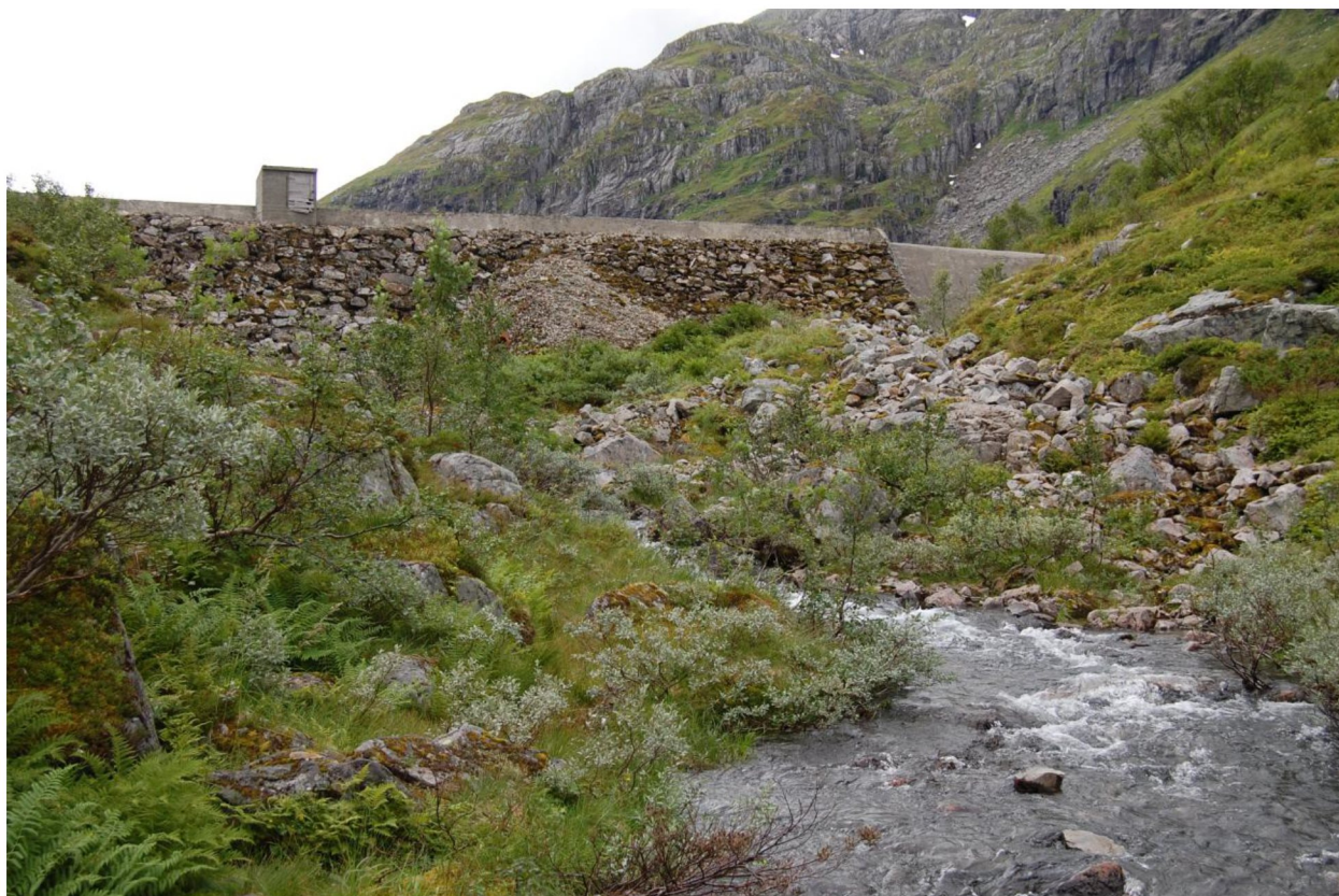
Bilde 2 viser eksisterende dam ved utløpet av Osvatnet.
