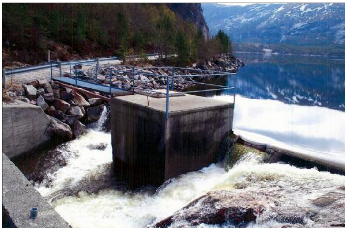
Figur 1. Demningen i utløpet av Slørdalsvatnet, med tappeluken for slipp av minstevannføring i midten.
