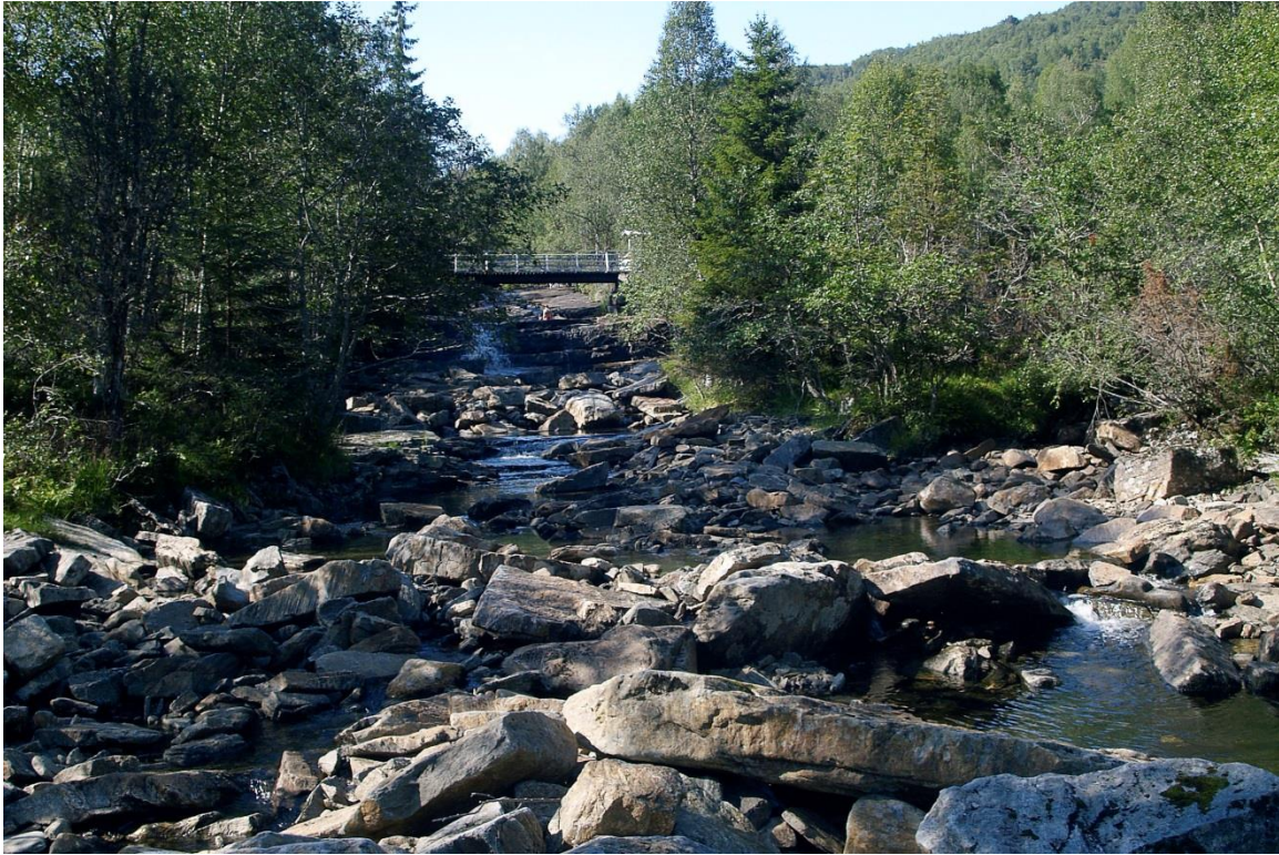
Bilde 1: Inntaksområdet, 21. juli 2014. Låg vassføring \approx 0,3 \text{ m}^3/\text{s} .
