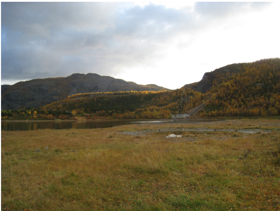
Bilde 5: Østre del av Kåfjordbotn sett fra utløpet av Sivertelva, Mattisfoss kraftverk midt i bilde.
