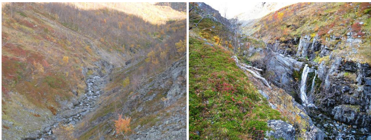
Figur 2-1 Inntaksområde. Bilde til venstre viser kløften som neddemt danner inntaksbassenget. Til høyre vises plasseringen av buedammen. Bunn av buedam etableres like oppstrøms den lille bekken på bildet.
