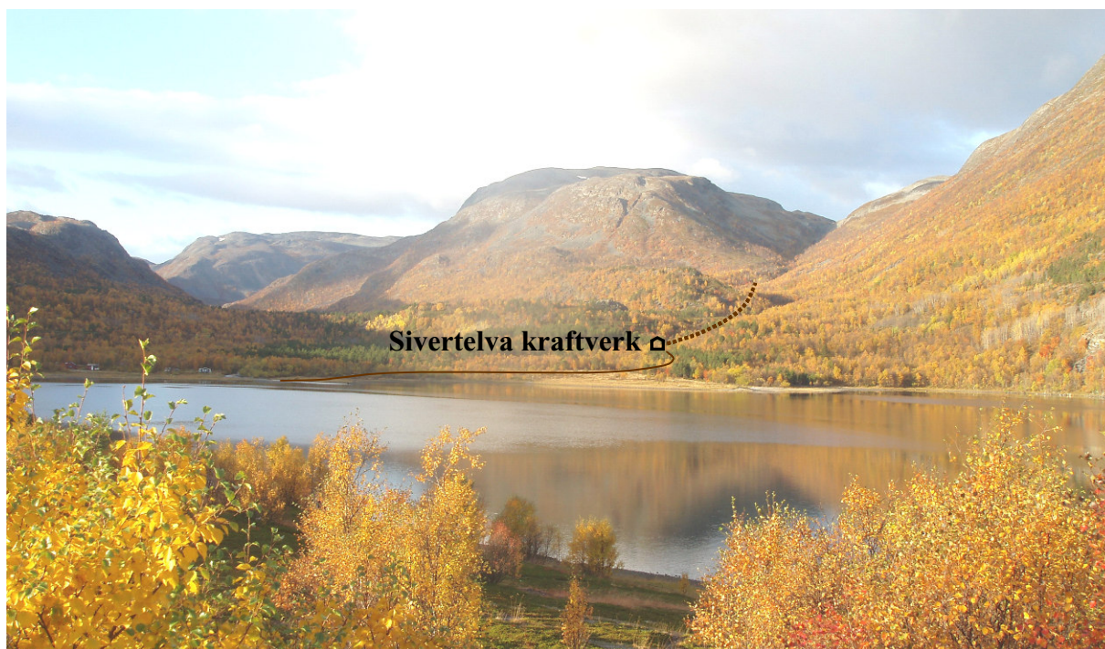
Figur 2-1 Sivertelva kraftverk ved Kåfjordbotn i Alta kommune.
