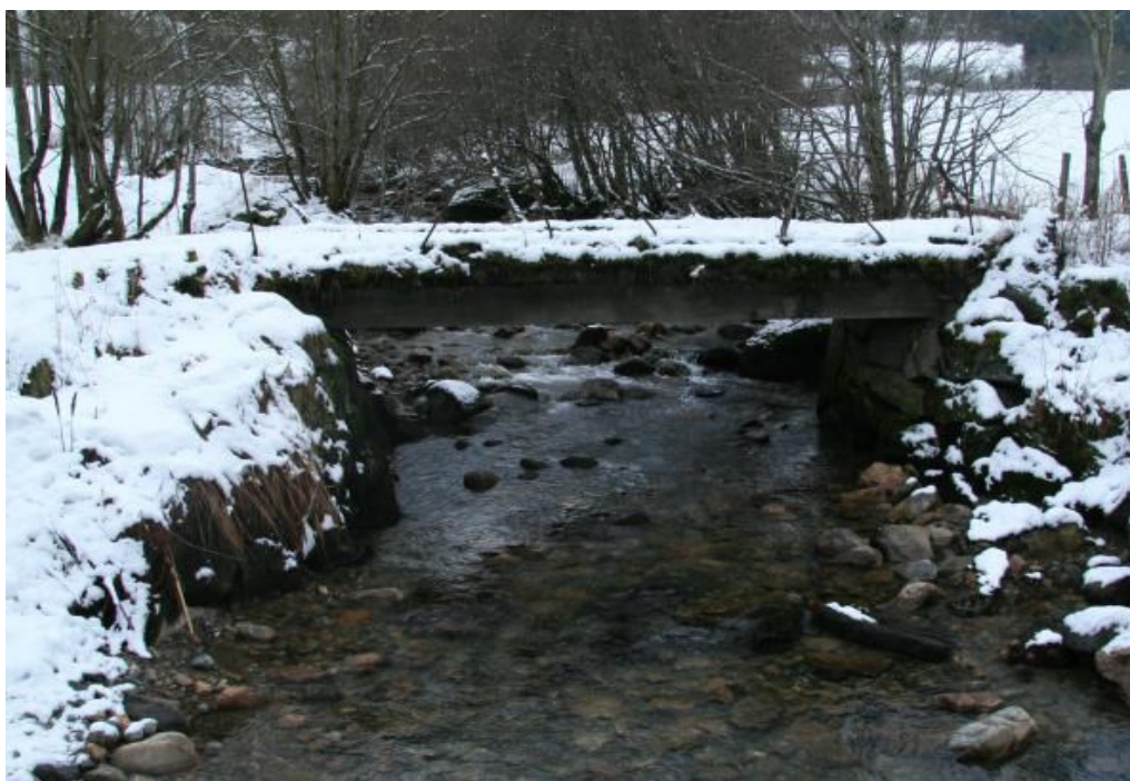
Bru over elva, eit stykke nedanfor vassverket. 26.12.2008. Vassføring ca. 0,3 m 3 /sek.
