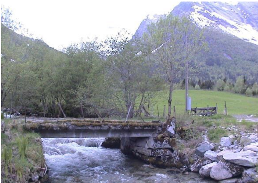
Bru over elva, eit stykke nedanfor vassverket. 16.05.2008. Vassføring ca. 1,2 m 3 /sek.
