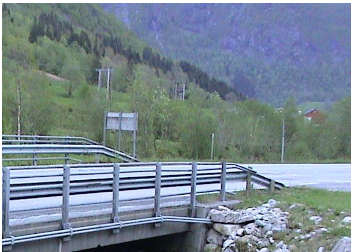
Bilde 5.1 Eksisterende 22 kV kraftlinje i bakgrunn på bilde
