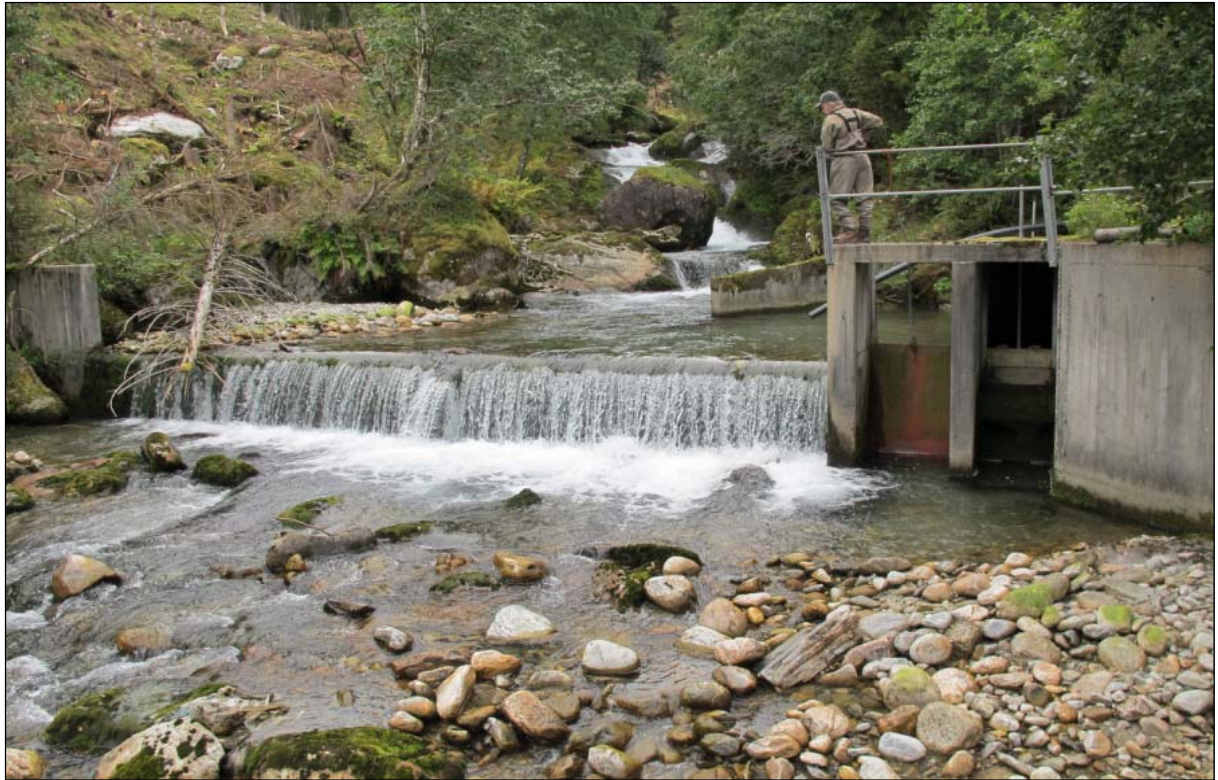
Figur 10. Inntaket til vannverket. Like over dammen er en foss som vi vurderer som endelig vandringshinder.
