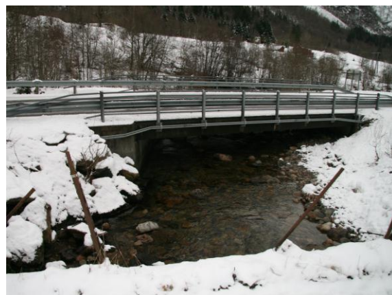
Bilde 1.8 Riksveibru 26/12-2008 – ca 0,3 m 3 /s
