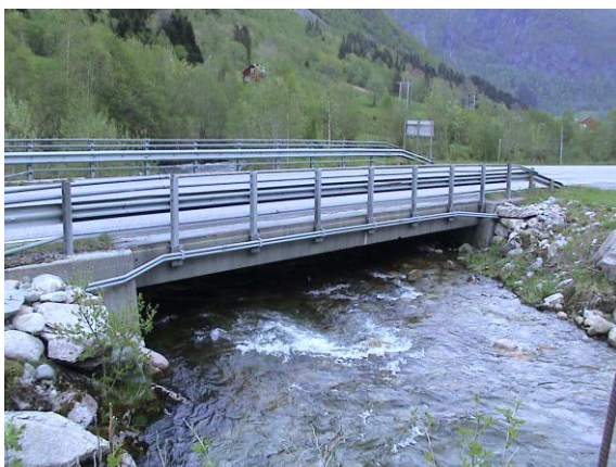
Bilde 1.7 Riksveibru 16/5-2008 – ca 1,2 m 3 /s
