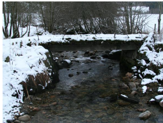
Bilde 1.6 Bru ved vei 26/12-2008 – ca 0,3 m 3 /s
