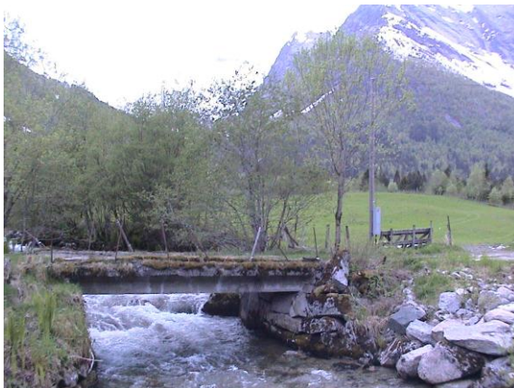
Bilde 1.5 Bru ved vei 16/5-2008 – ca 1,2 m 3 /s
