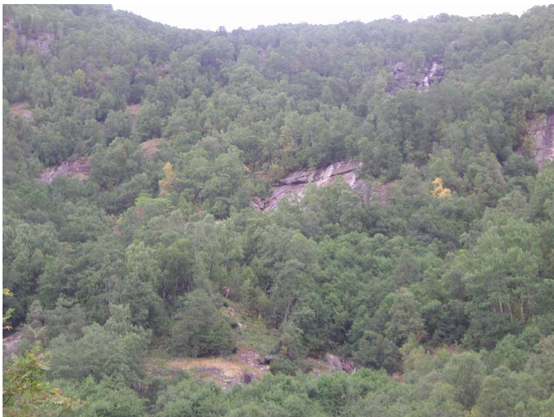
Oversikt rørgate ved bratt parti
