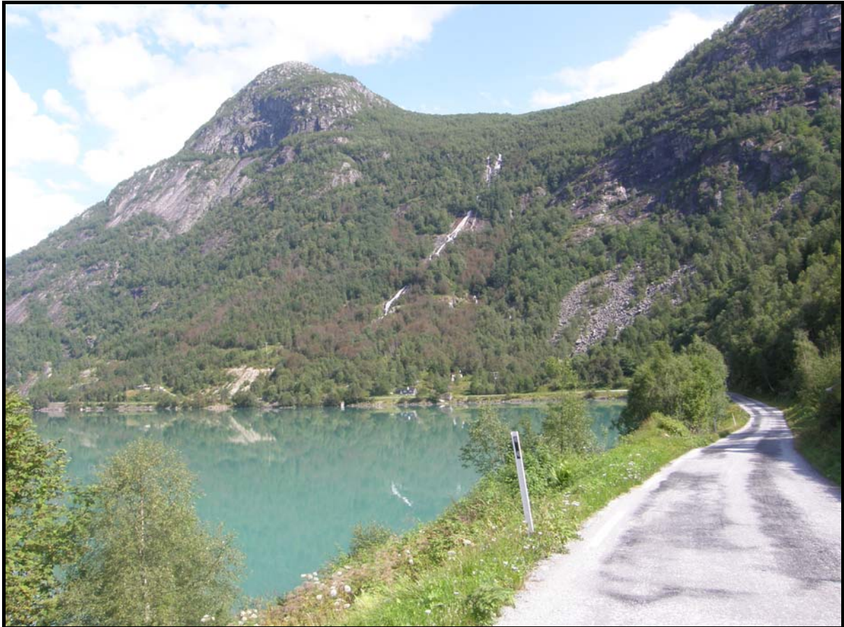
Figur 1: Oversiktsbilde av Viki og Ugledalen. Garden Ugulsvik ligg opp til høgre for vegen. Kraftstasjonen er planlagt plassert under sandtaket.
