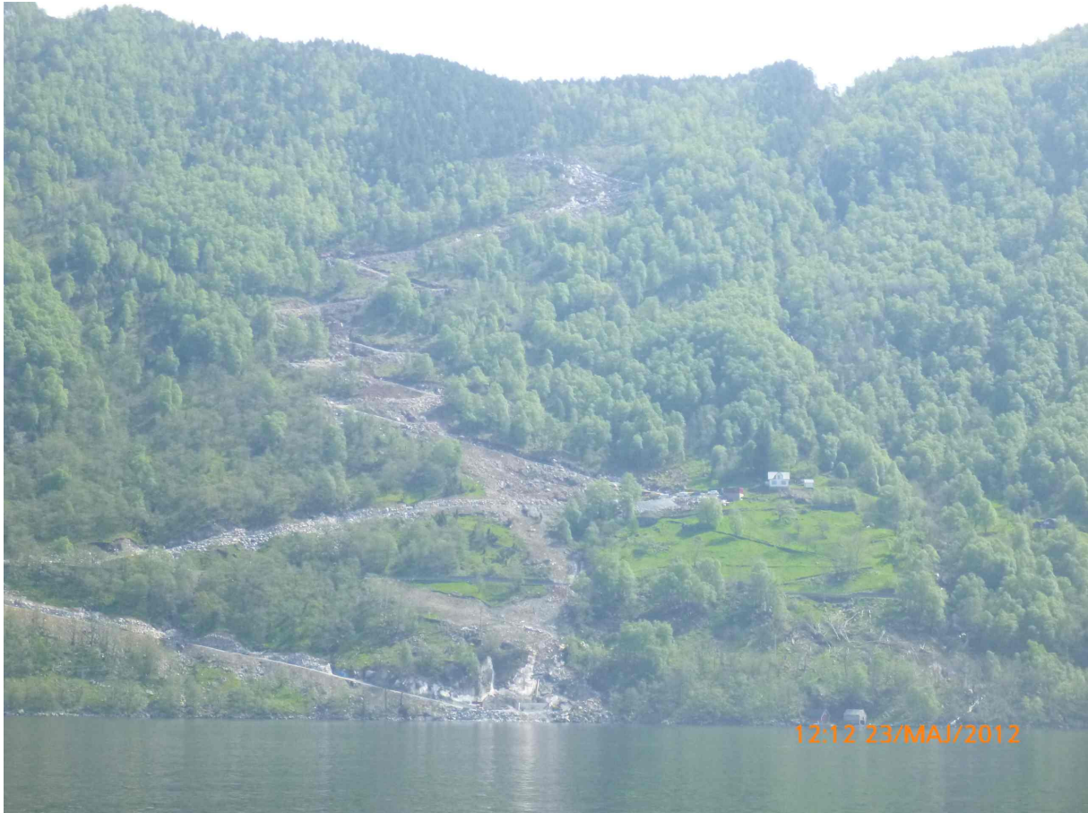
Illustrasjonsfoto: Anleggsveg i bratt terreng for utbygging av småkraftverk i Sogn og Fjordane. Foto: Bjarte Skår Brødrene Dahl A/S
