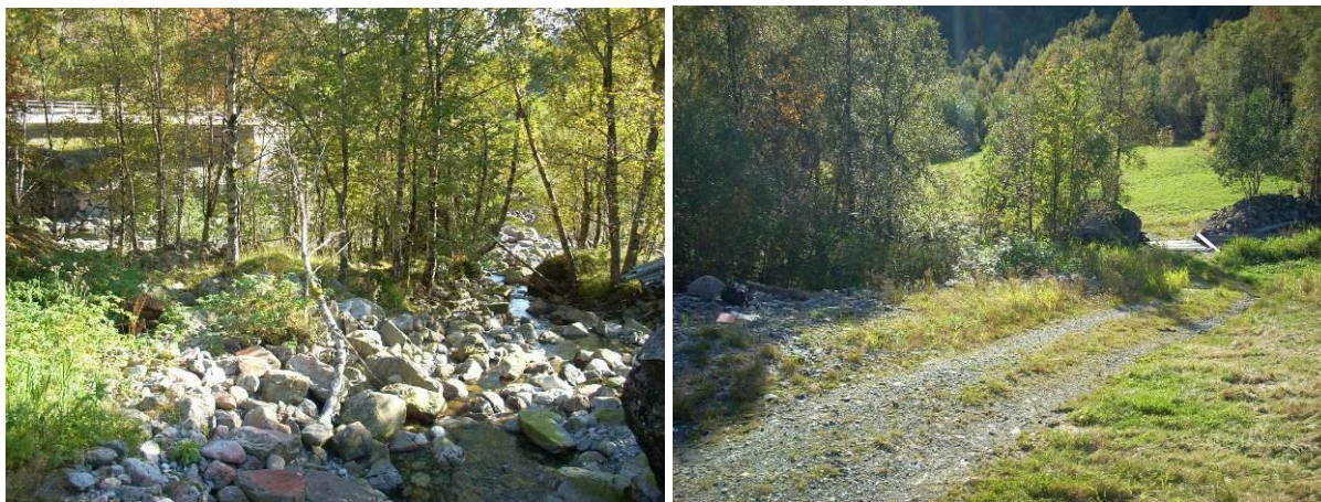
Bildet til venstre viser Stølsånas utløp i Brattlandsåna. Kraftstasjonen er planlagt plassert til venstre i begge bildene over. Fotos: Ole Roer.
