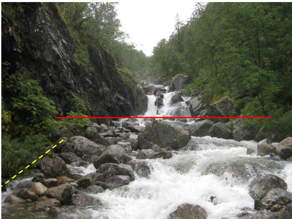
Bilde 6: Damsted i Kolåsåna sett fra nedstrøms side. Damkrone ved rød strek. Foto: Elvekraft.
