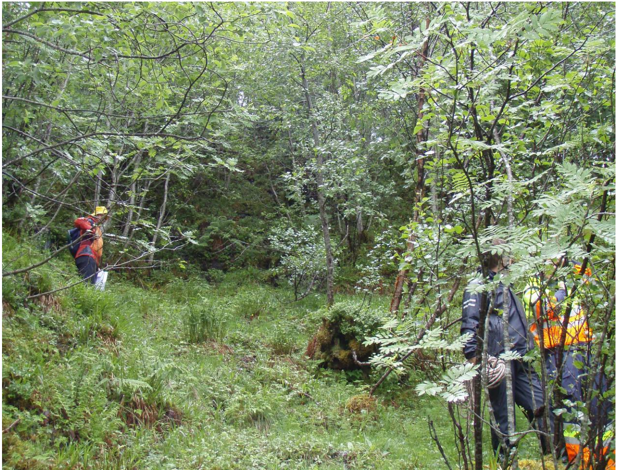
Fra området der rørgata til Malme og Røshol kraftverk blir lagt. Bildet er tatt rett ovenfor området for den planlagte kraftstasjonen.
