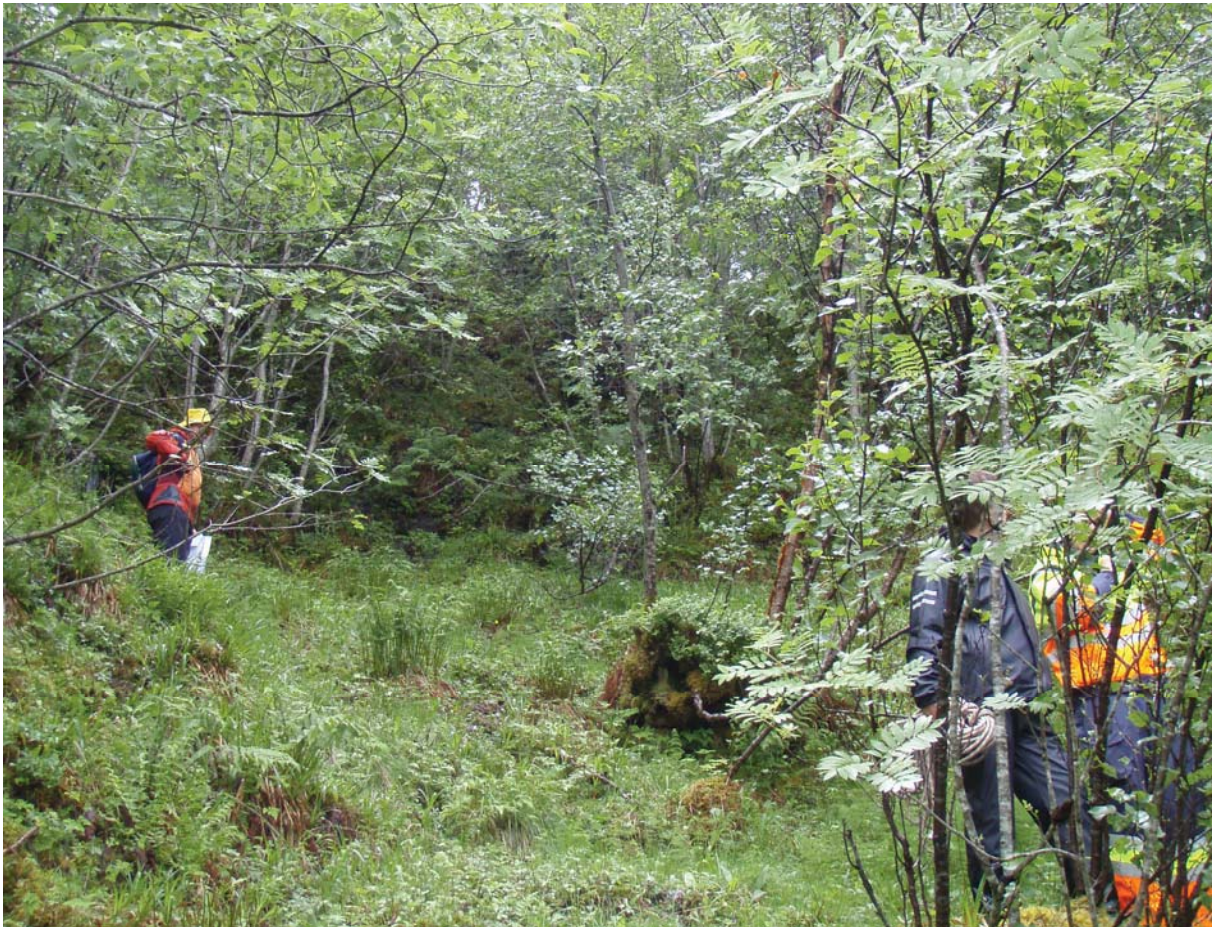
Fra området der rørgata til Malmeelva kraftverk blir lagt. Bildet er tatt rett ovenfor området for den planlagte kraftstasjonen.
