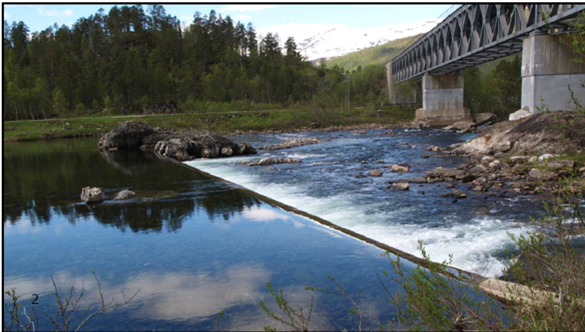
Figur 1-2 Jernbanebru og terskel i Ranaelva. E6 på motsatt side.
