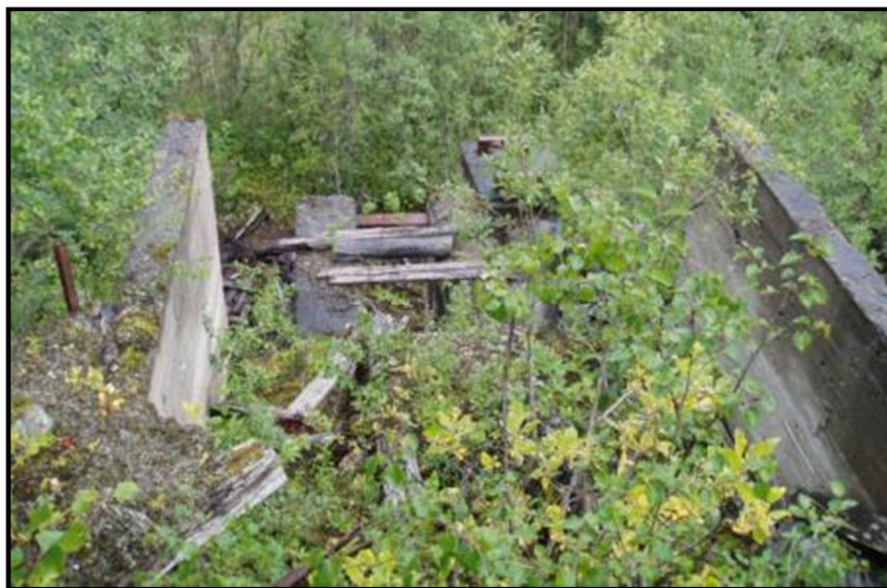
Figur 5-14 Restene etter en vinsj står fortsatt på Hjartås, i skråningen nord for de store massetakene. Vinsjen ble trolig brukt ved byggingen av Nordlandsbanen under 2. verdenskrig (foto: M. Mortensen, sept. 2007)
