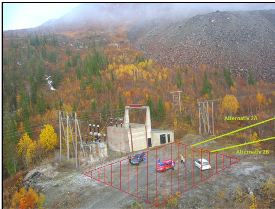
Figur 3-18: Ørtfjell transformatorstasjon (Foto Helgelandskraft)
