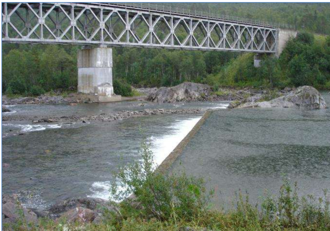
Figur 3-2 Eksisterende terskel ved ca. kote 245 i Ranaelva.
