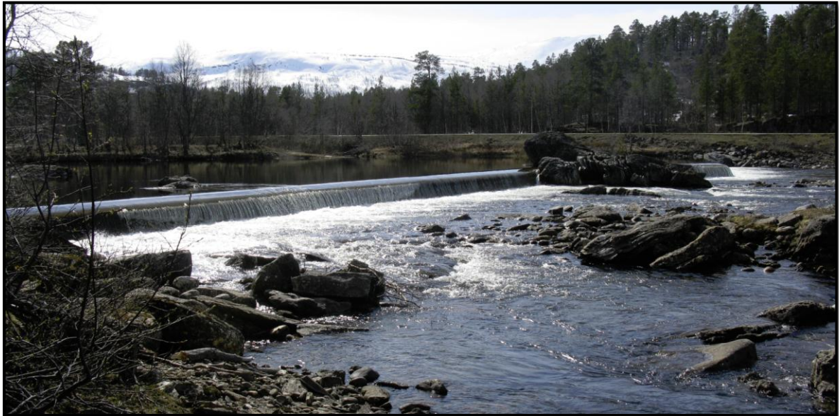
Figur 22 Område ved planlagt inntak i Ranaelva
