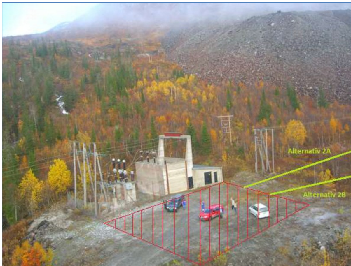
Bilde 1: Bilde av Ørtfjell transformatorstasjon, med innføring av traséalternativ 2A og 2B fra første søknad. Bak ser man deler av Rana Gruber sitt dagbrudd for jernmalmsvirksomhet. Kilde: Miljøkraft Nordland, 2014.
