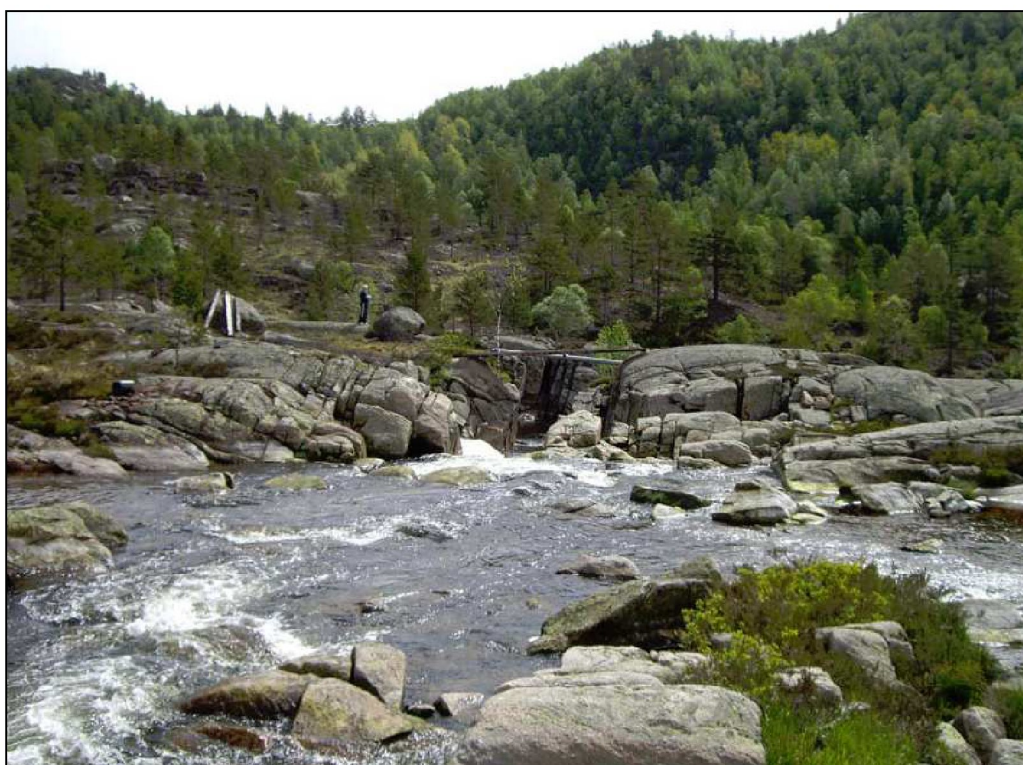
Figur 2.4. Bilde som viser planlagt inntak for alternativ 2. Kløfta som hovedstrømmen følger viser i sentrum av bildet. Ved stor vannstand deler elva seg slik at det også renner vann i et løp til høyre for bildet. Dette andre løpet vil benyttes til inntak, og det vil måtte bygges en 10 meter bred lededam på 2 meters høyde for å få til dette. Foto: Fra konsesjonssøknad
