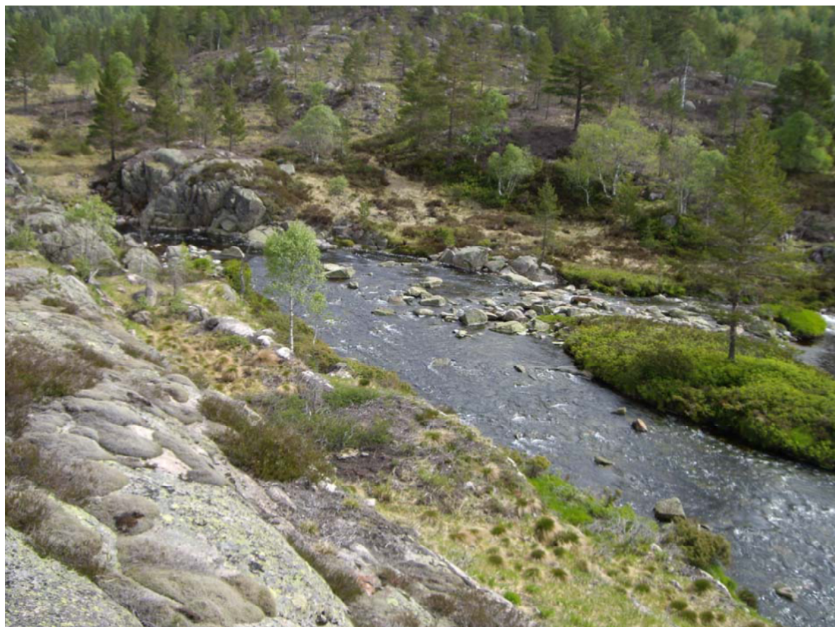
FIGUR 11: BILDE AV OMRÅDE FOR PLANLAGT KRAFTSTASJON.
