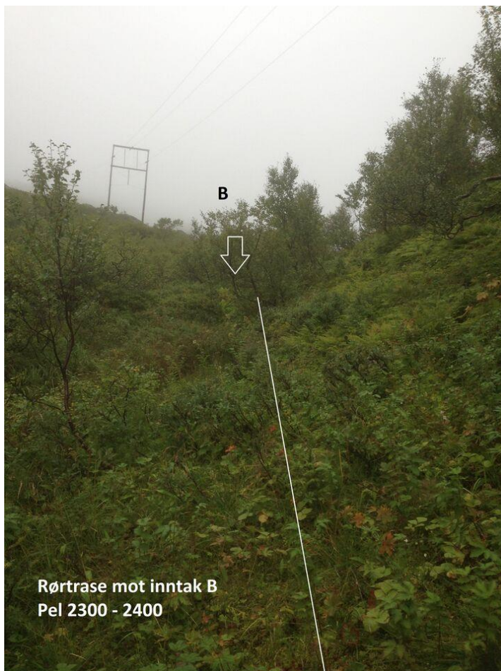
Bilde 2-4 Rørgate rett ved inntaket. Referanse på bilde viser til detaljkart (vedlegg 3).
