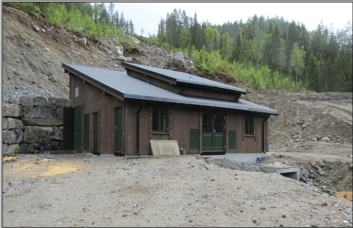
Bilde 2-10 Bilde av en tilsvarende stasjon.
