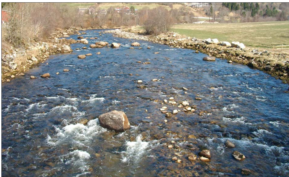
Figur 17. Storelva like ovenfor Seimebrua den 21/4-2010. Vannføringen på bildet er beregnet til ca. 5,4 – 5,5 m 3 /s. Dette tilsvarer ca. 78 % av middelvannføringen i sommerhalvåret etter utbygging (ca. 6,9 – 7,0 m 3 /s).
