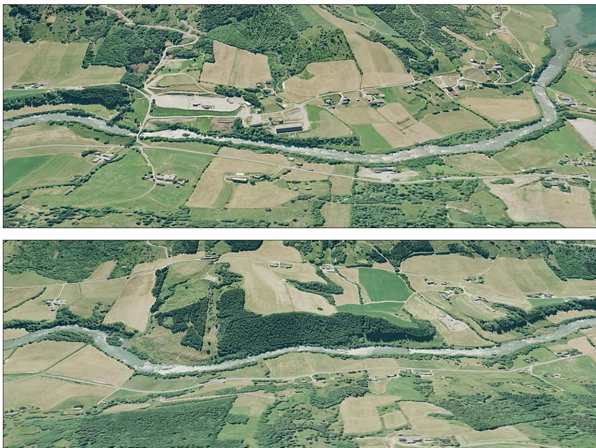
Figur 20. Det er ingen erosjon i tilgrensende løsmasser langs Storelva i dag (elva er forbygd langs store deler av den aktuelle elvestrekningen).
