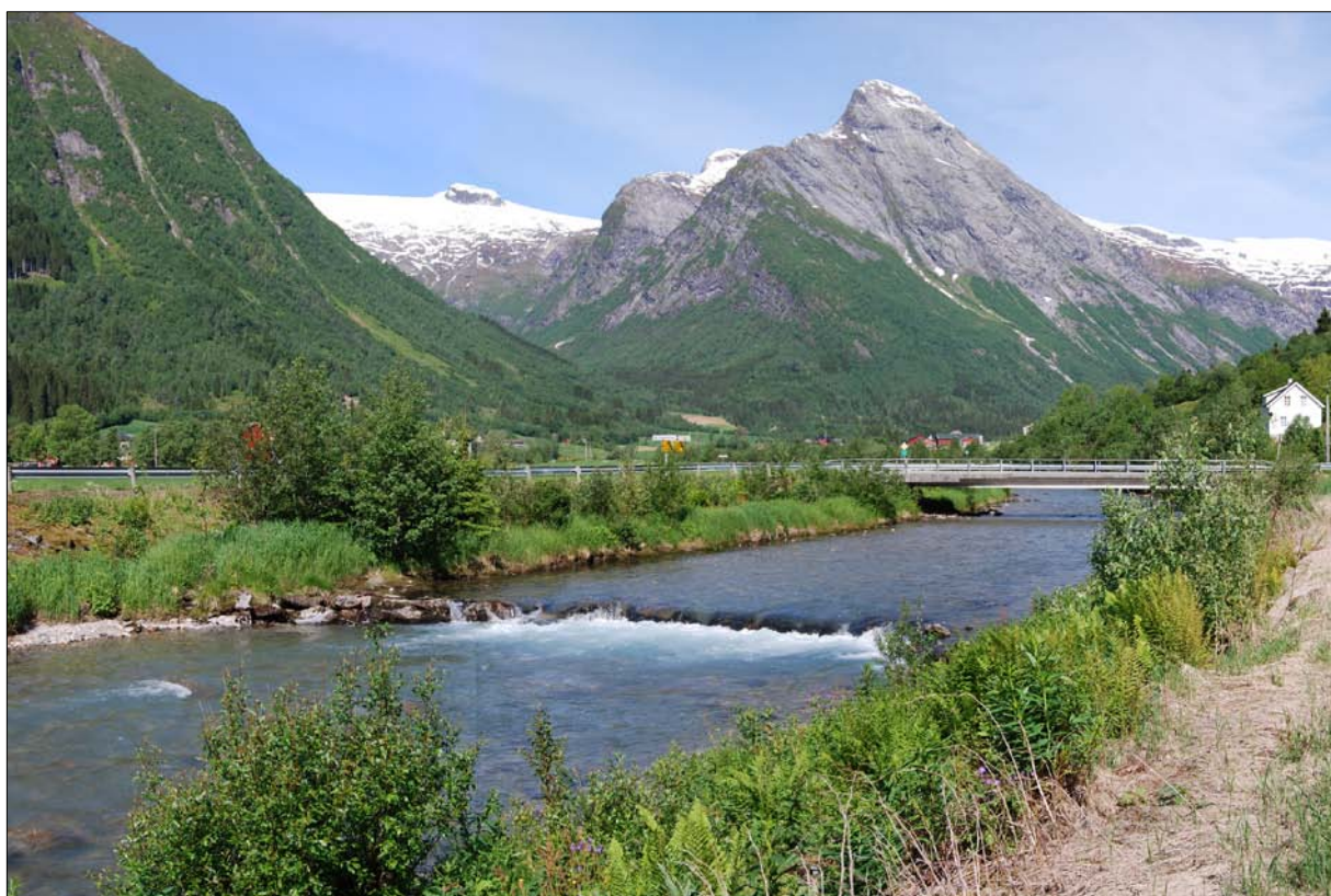
Figur 20. Bilde viser terskel ved Storelva i Fjærland.
