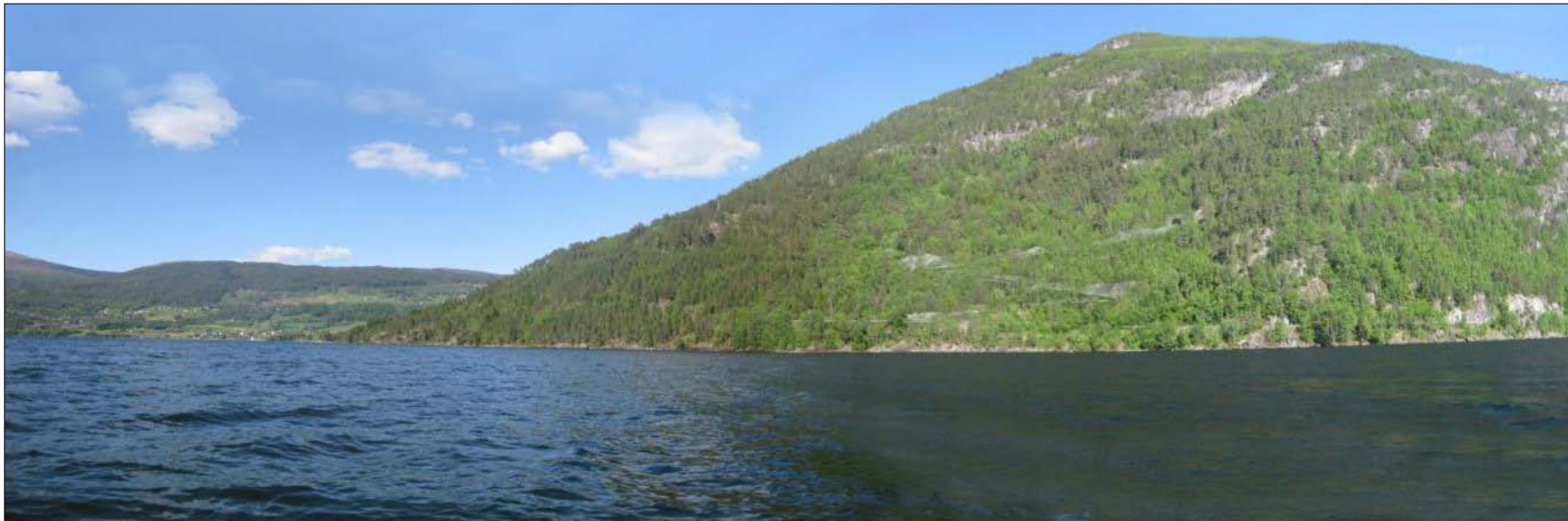
Manipulert bilde over kraftstasjonsområde med adkomstveg, stasjon i fjell og jordkabel
