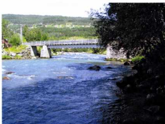
Seimsbrua sett nedenfra.
