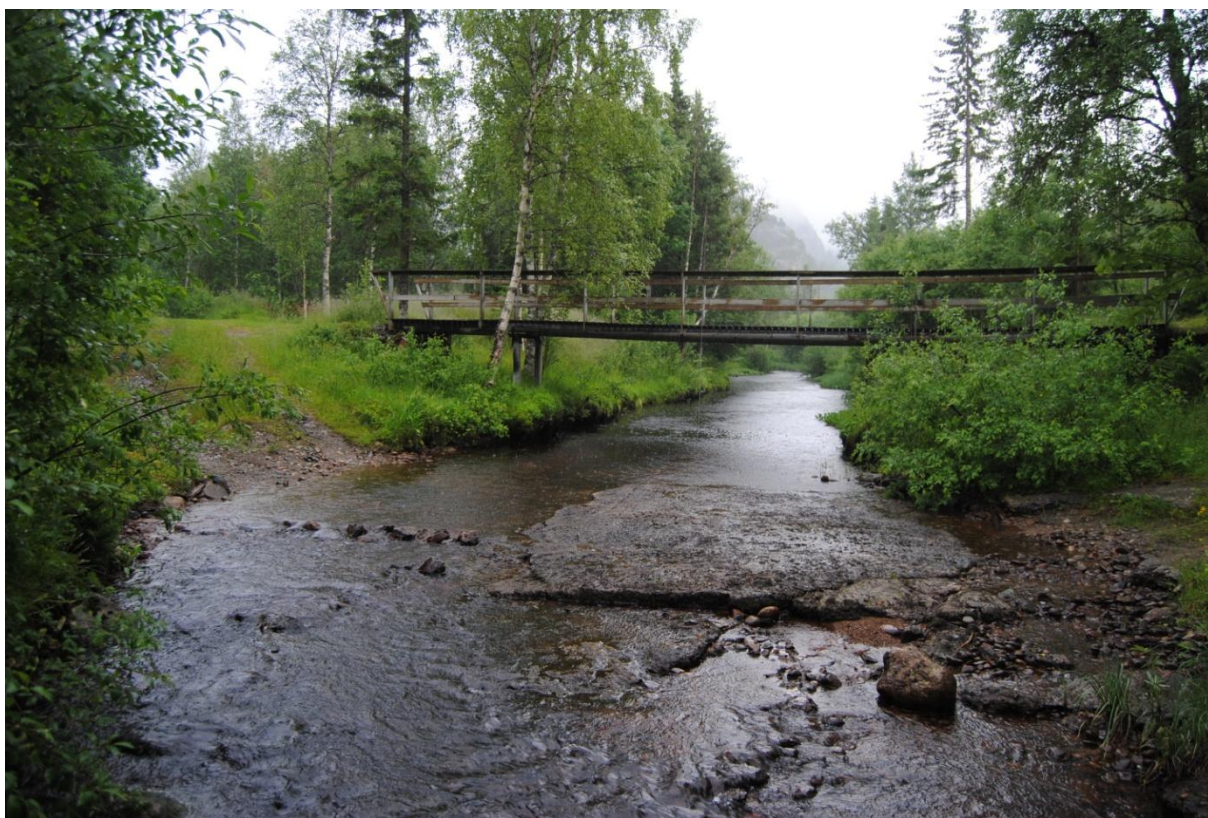
Bilde 16 Alternativ reguleringsdamplassering, sett oppstrøms.
