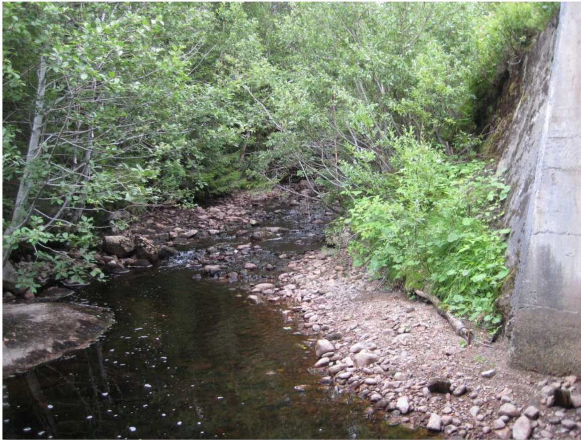
Bilde 6 Inntaksplassering oppstrøms kulvert og kryssing av Rv 766, sett motstrøms.
