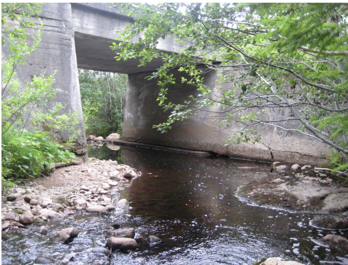
Bilde 12 Oppstrøms kryssing av Rv 766.
