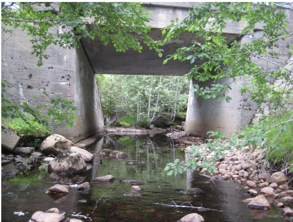
Bilde 13 Nedstrøms kryssing av Rv 766.
