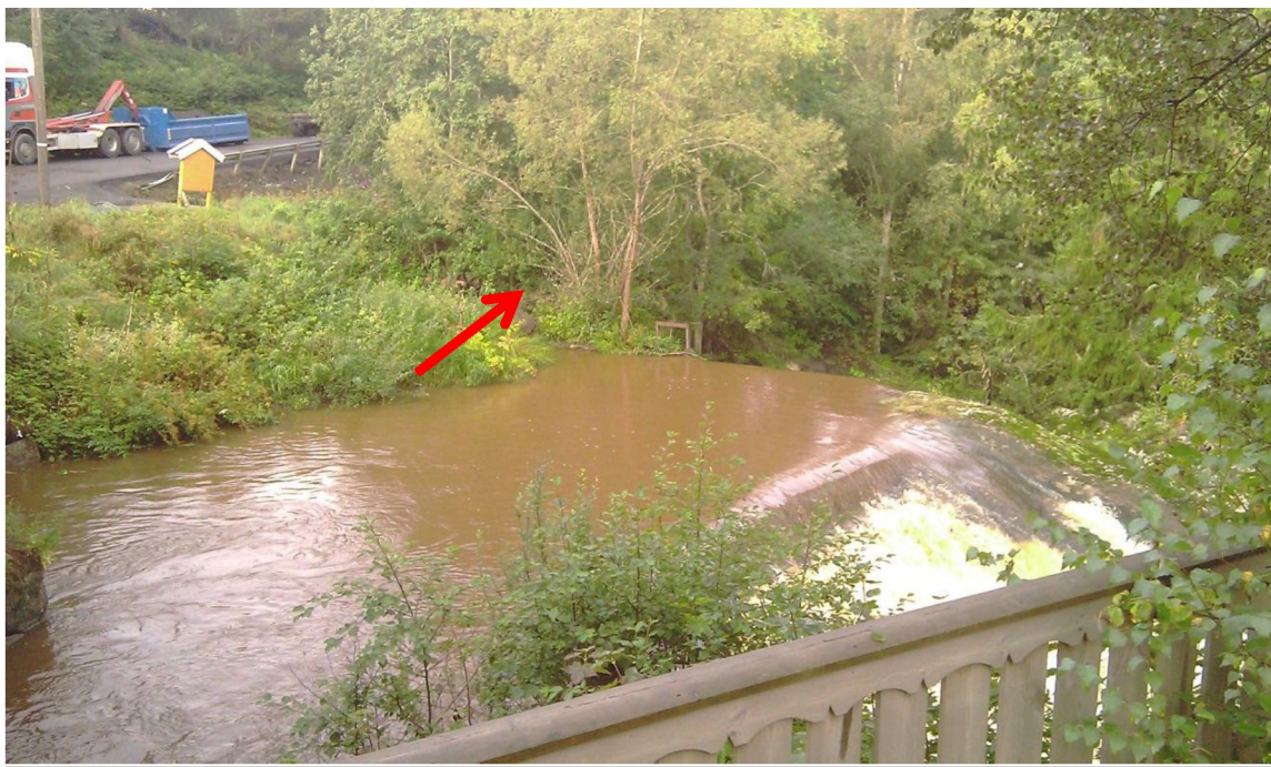
Bilde viser dagens dam. Pil antyder området for nytt inntak.
