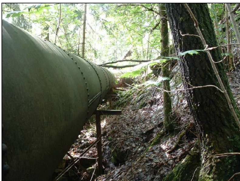
Den gamle rørgata i lia nord for Grønnfoss
