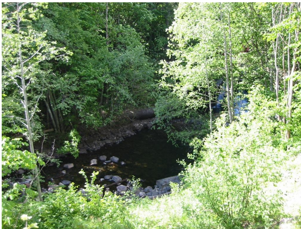
Bilde nr 8 Eksisterende rørgate ved Klapperdammen, inntaksdam til Sjøstad 2 kraftstasjon
