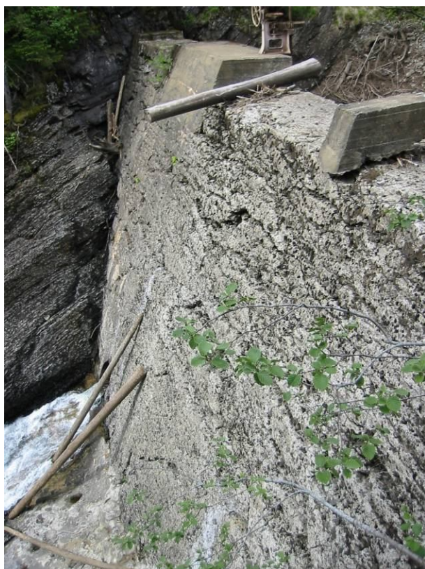
Bilde nr 3 Nedstrøms side Høgfosdammen
