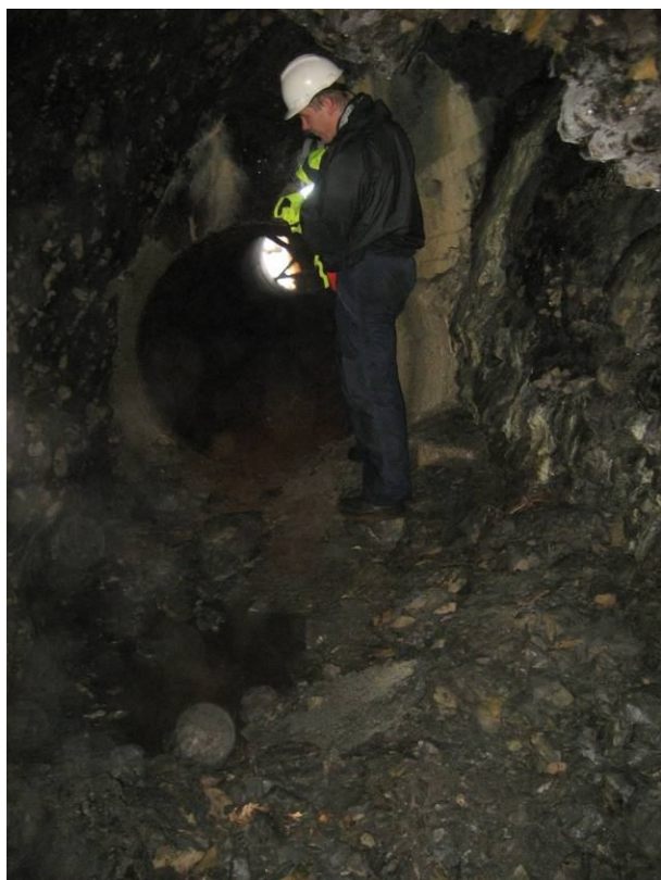
Bilde nr 4 Tunnelen, oppstrøms propp med rør fra inntak
