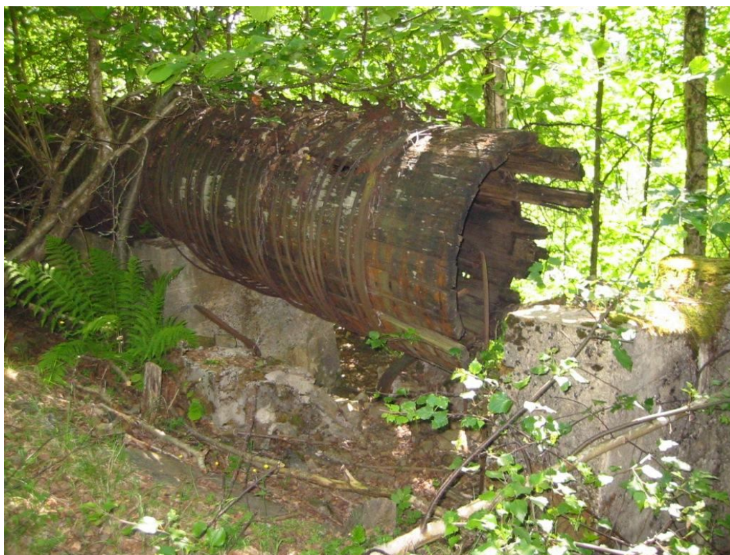
Bilde nr 5 Eksisterende rørgate, trerør, ca 1100mm
