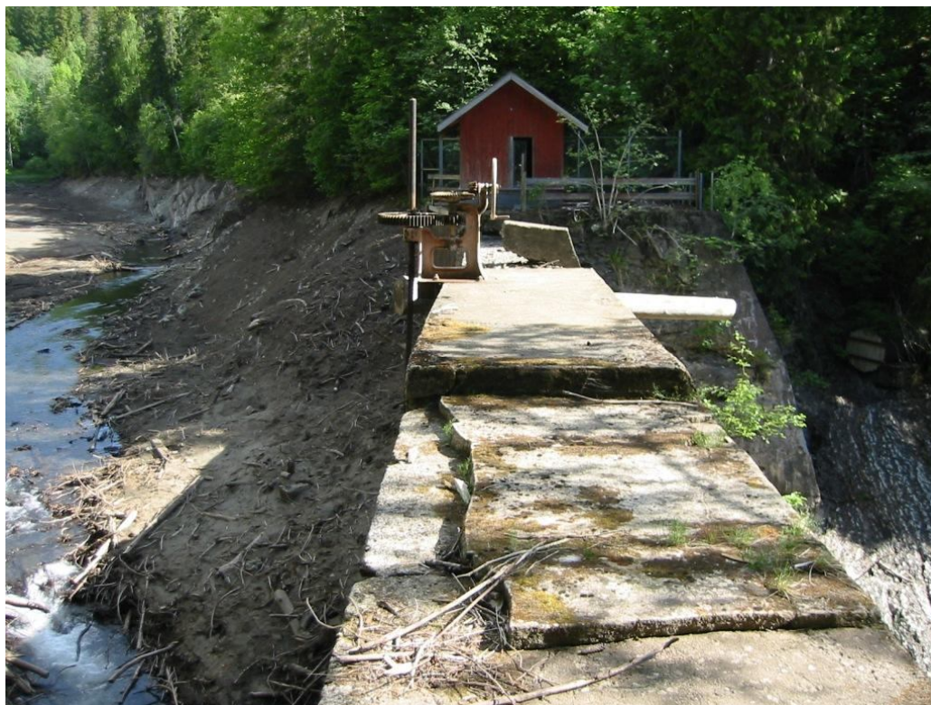
Bilde nr 2 Høgfosdammen med inntak. Blendet rør til tunnel i bakgrunnen.
