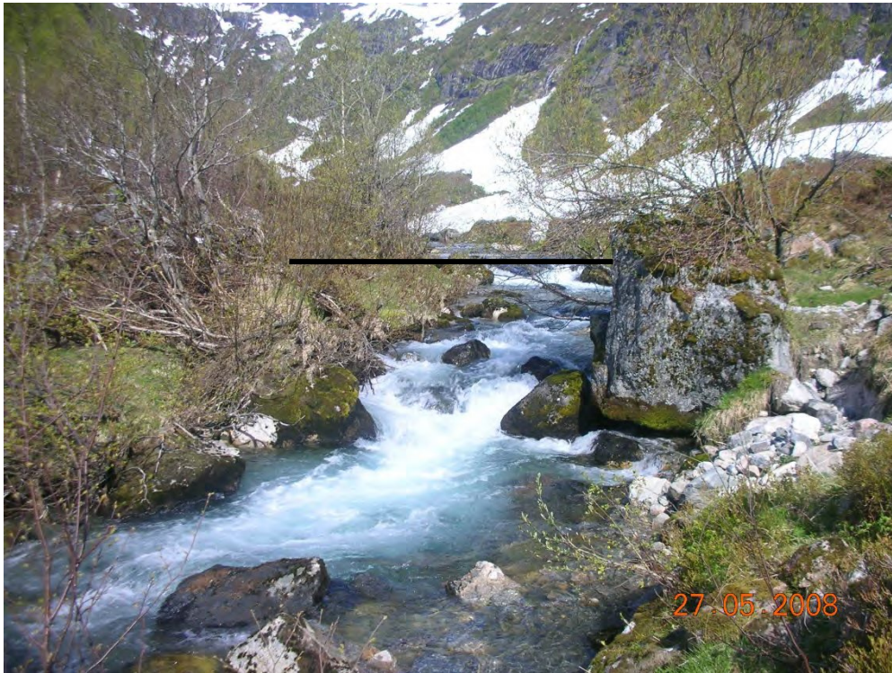
Foto 1. Damområdet sett frå nedstrøms side. Damtopp illustrert med svart strek. Dammen vert plassert oppstrøms stor stein til høgre i bilete.
