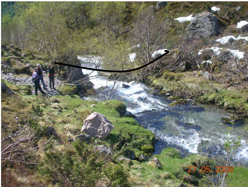
Foto 2: Damområde sett frå oppstrøms side. Dam illustrert med svart strek. Stor stein som vist på førre bilete visar til venstre i bilete.
