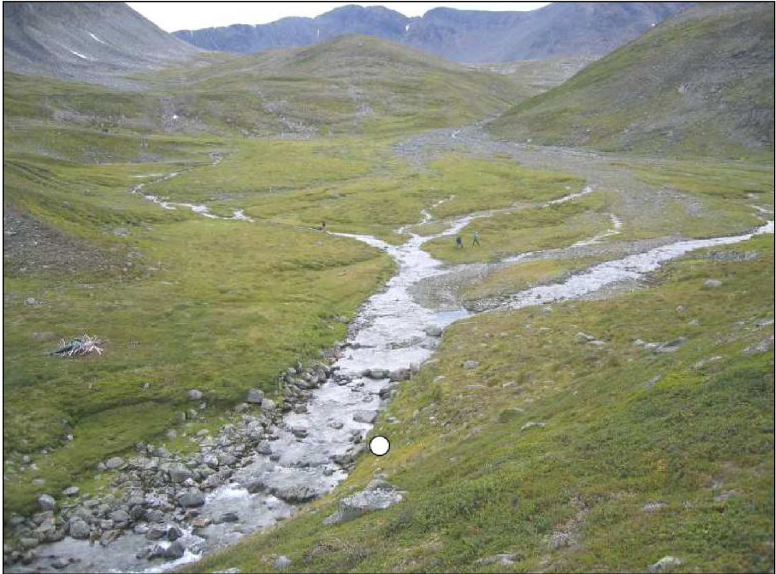
Figur 5. Inntaket til kraftverket i Gjerdelva vert lagt til kote 587, som her er markert med kvit prikk (foto: Torgeir Johnson, Norconsult).
