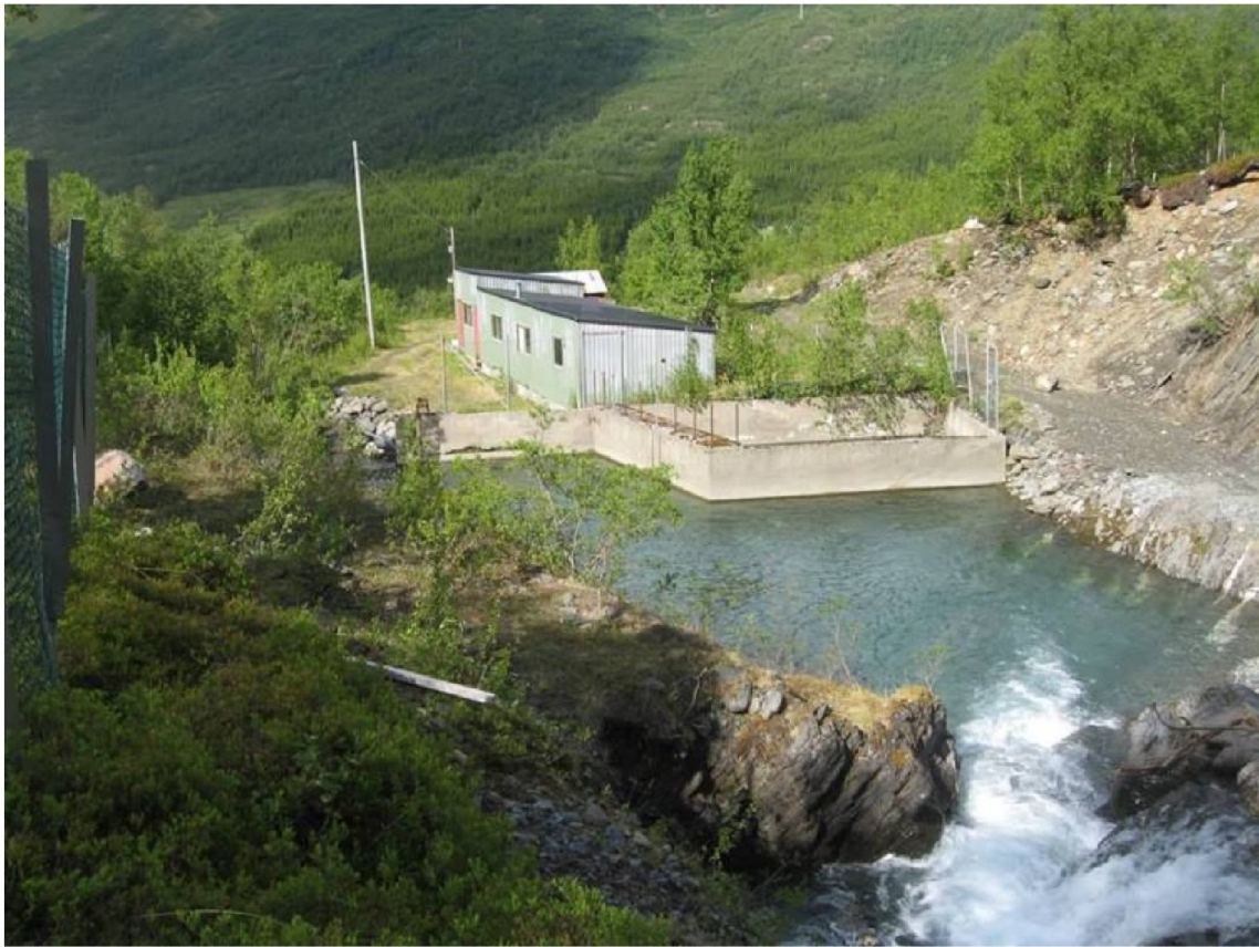
Bilde 7: Lyngseidet vannverk.
