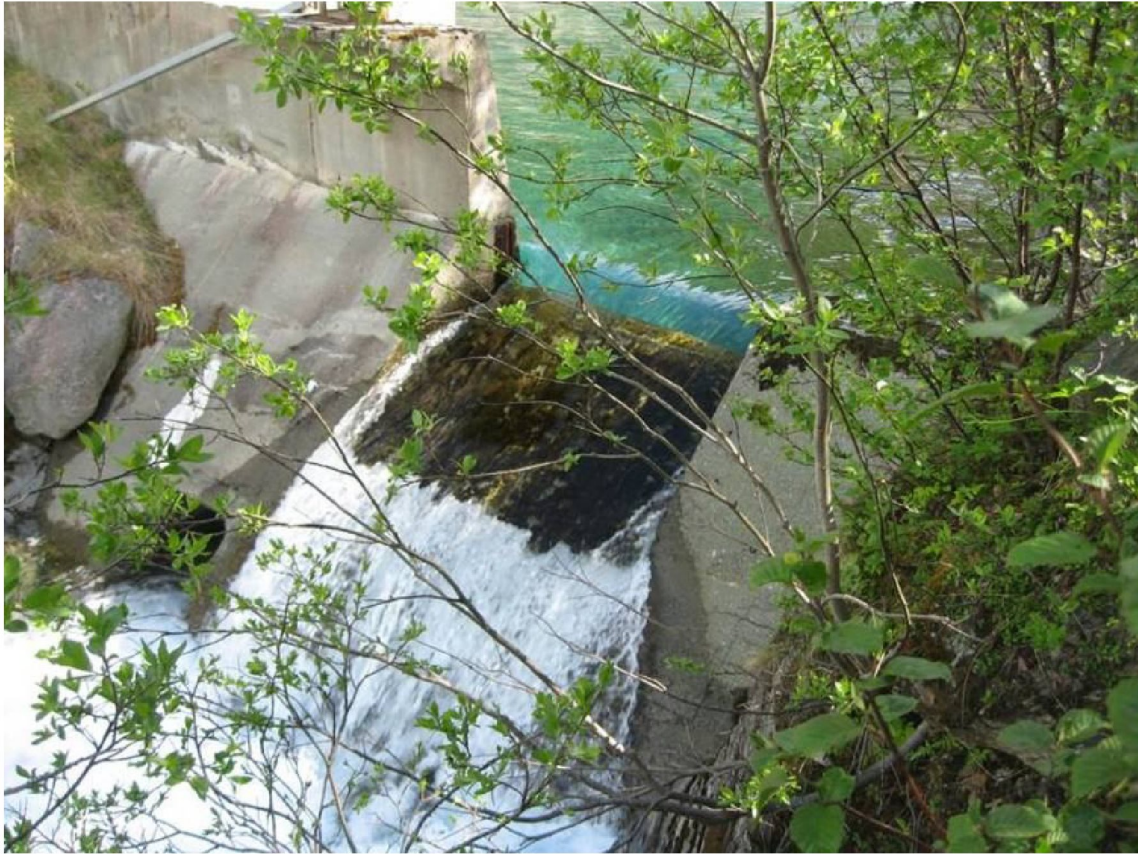
Bilde 8: Vannoverløp fra bassenget til vannverket.
