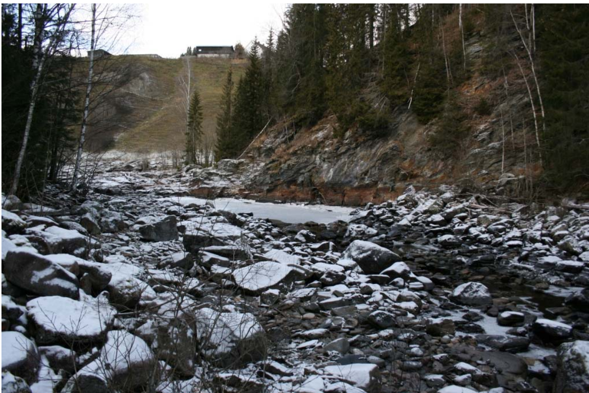
Bilde 3. Nedre kulp sett fra kraftverksutløpet og oppover, november 2007. Tilnærmet ingen vannføring over dammen, og det er tørt mellom kulpene og fra nedre kulp til kraftverksutløpet (Foto: Finn Gregersen).
