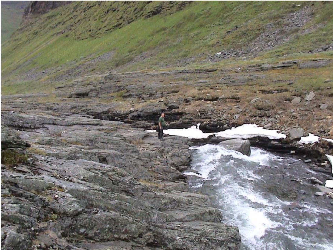
Bilde 1.1 Inntak og demning sett ovenfra kote 640 moh
