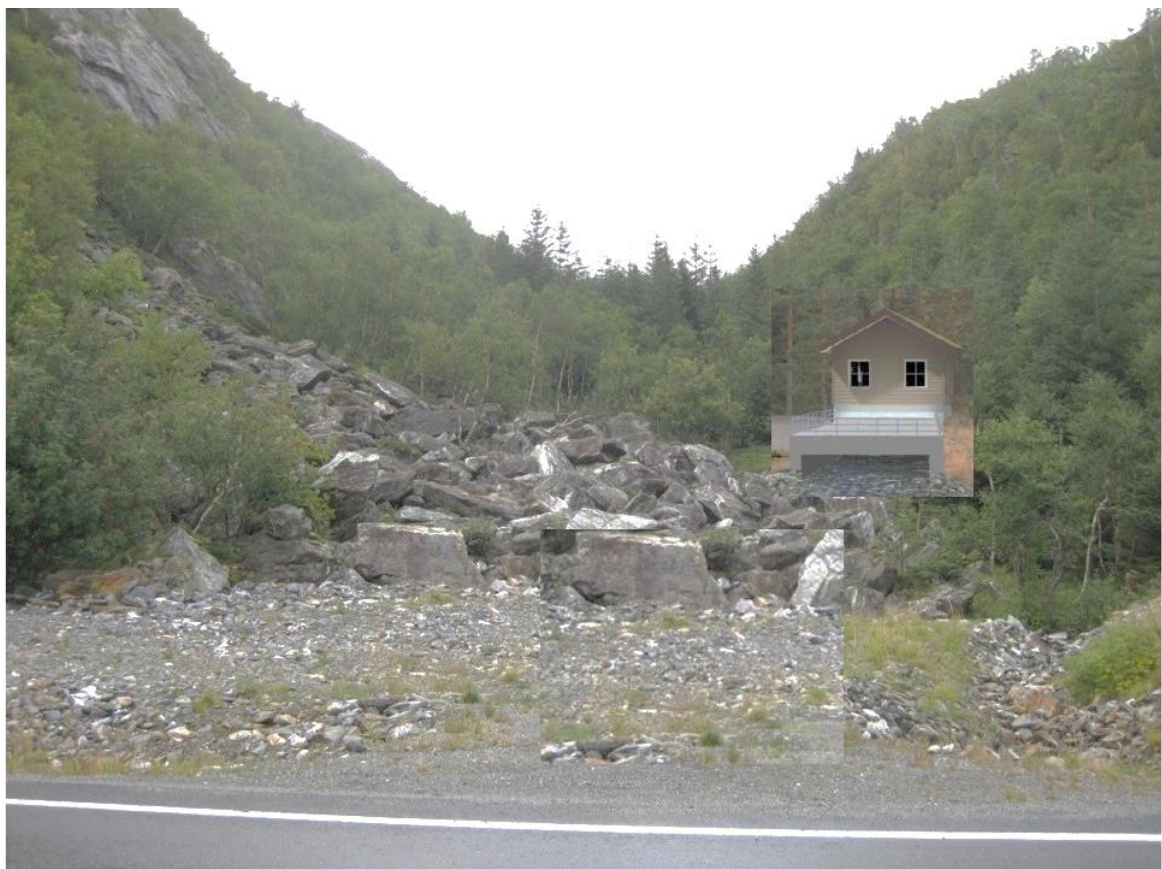
Bilde 4. Montasje stasjonstomt
