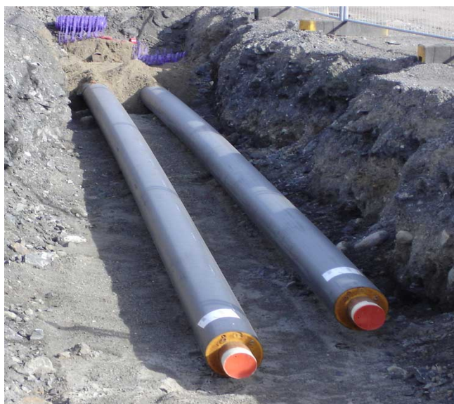
Figur 4-4, Fjernvarmerør fra bygging
