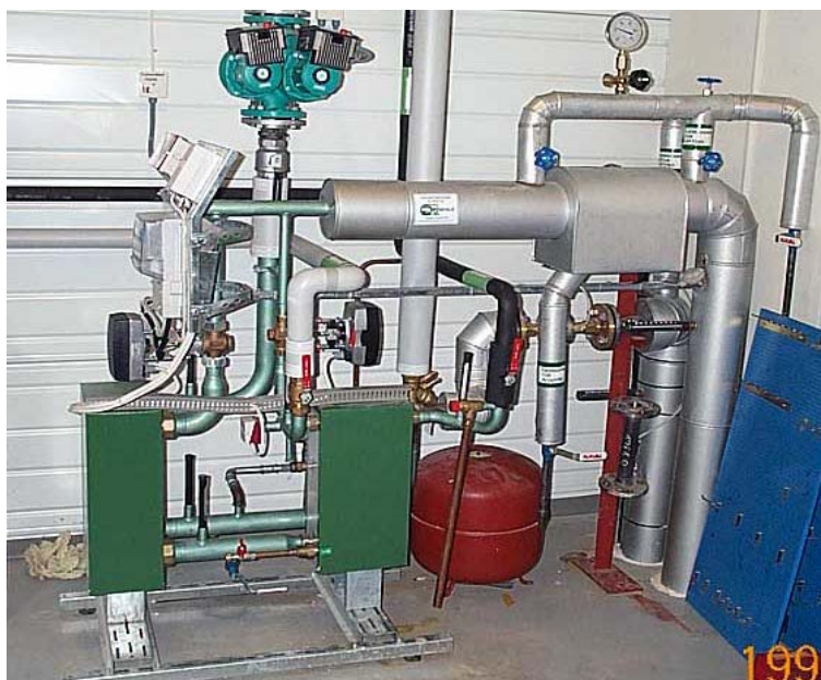
Figur 2 Eksempel på kundesentral med vekslere for varmt tappevann og oppvarming
