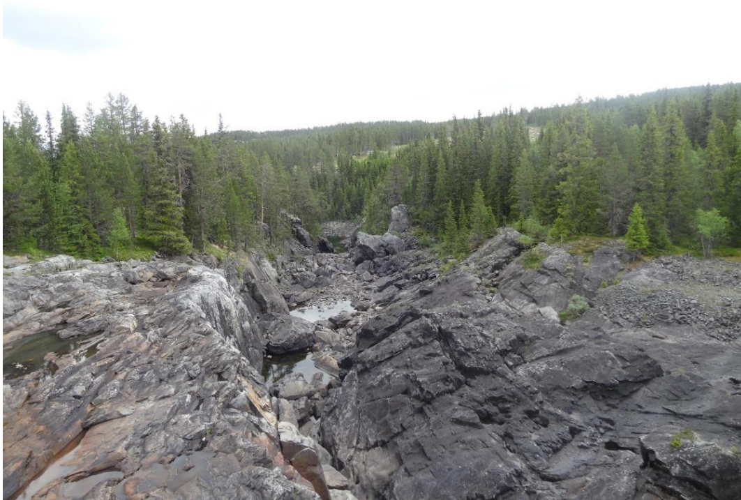
Bilde 1: Nedstrøms dam Bløytjern.
