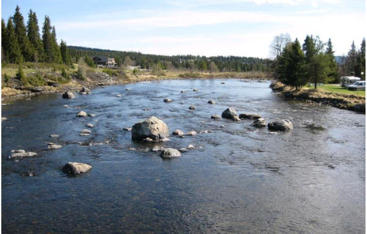
Bilde 4: Tisleia nedstrøms bru. Vannføring 1,2 m 3 /s
