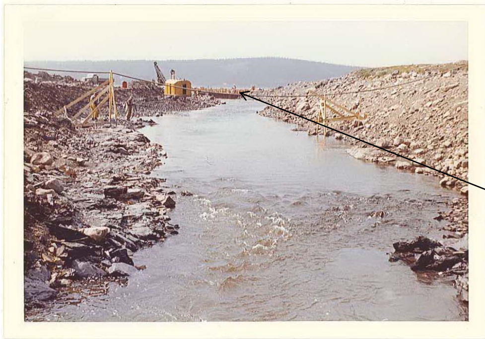
Fangdam sett fra nedstrøms side
