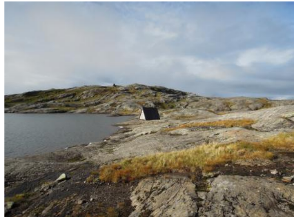
Figur 4.3. Sikringshytte ved et vatn øst i planområdet.
