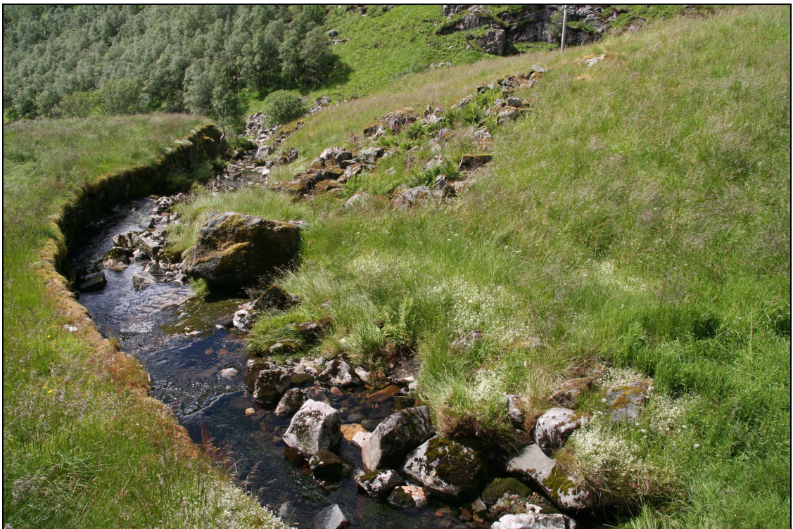
Figur 14. Øverst: Fossdalselva ved Fossdal, med ustabile elvekanter og lite vegetasjonsdekke. Nederst: Kanalisert sidebekk til Fossdalselva fra øst går i åpent landskap. Foto 25. juni 2008: Ole Kr. Spikkeland.
