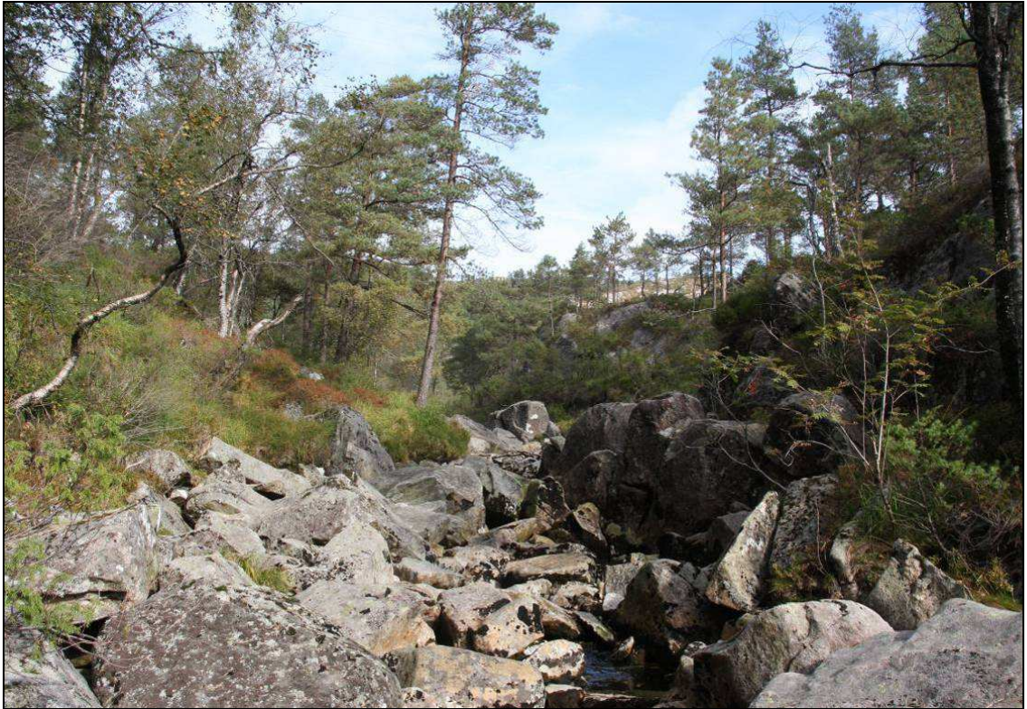
Figur 6. Ved inntaket i Dyrkollelva, kote 240, vil det bli bygd en 3 m høy og 20 m lang gravitasjonsdam. Foto 16. september 2008: Ole Kristian Spikkeland.
