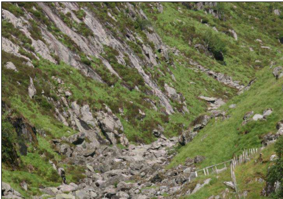
Figur 4. Hovedinntaket i Fossdalselva legges til kote 240, i bakkant på dette bildet. Det bygges en 3 m høy og 20 m lang gravitasjonsdam over elveløpet. Foto 25. juni 2008: Ole Kristian Spikkeland.
