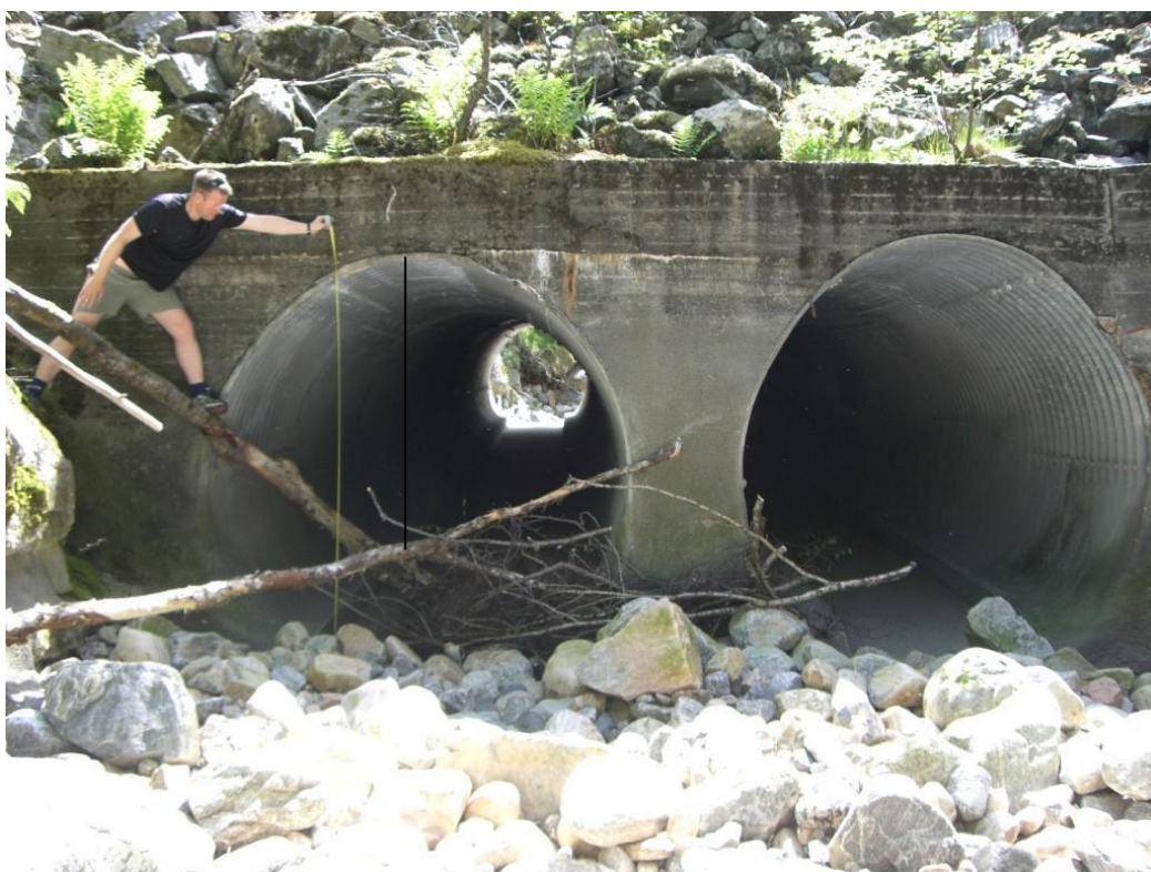
Bilde 6. Kulvert under Fylkesvei 379. 2 x \varnothing 2,7m.
