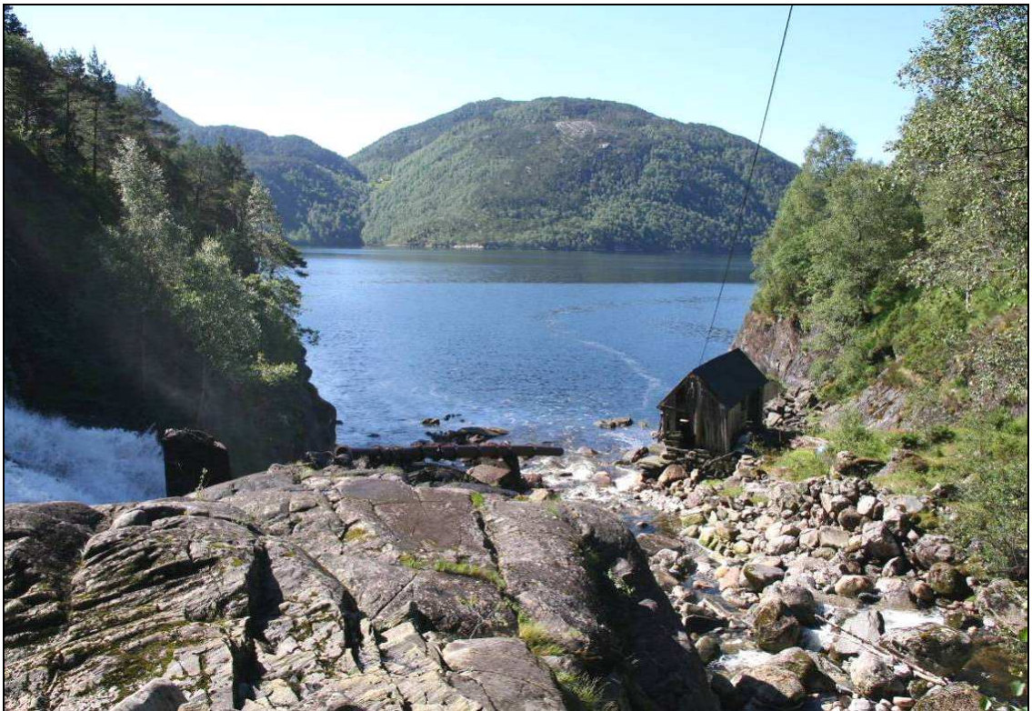
Figur 7. Fossdalen kraftverk er planlagt vest for utløpet av Fossdalselva nede til høyre. Kraftstasjonen vil ligge ovenfor den gamle saga, om lag kote 2. Fra venstre kommer elva fra Eikemo inn fra øst via den markerte Eikemofossen. Foto 25. juni 2008: Ole Kristian Spikkeland.
