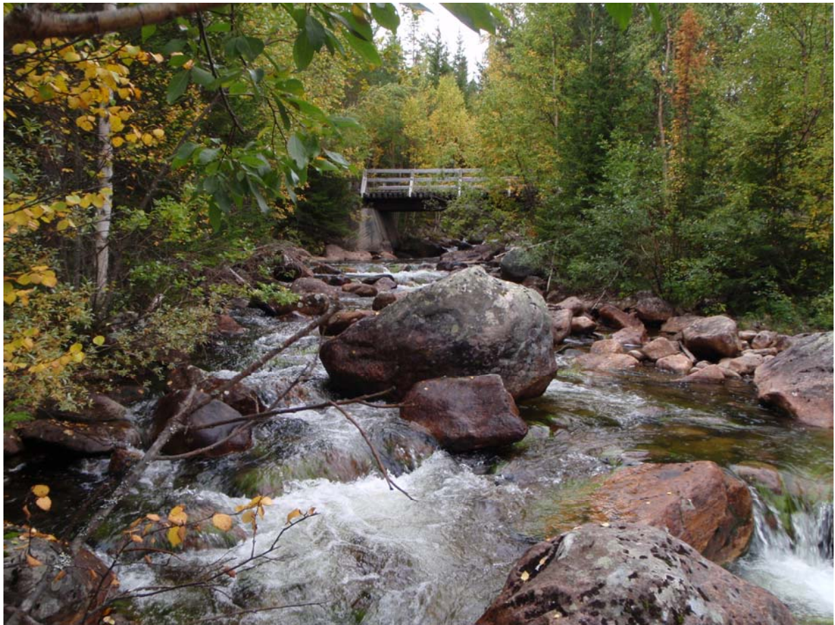
Figur 21 Bru over Storbekken 100 m oppstrøms utløp.
