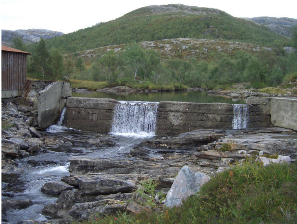
Bilde 7: Oversikt over inntaket til Tverlandet vannverk.
