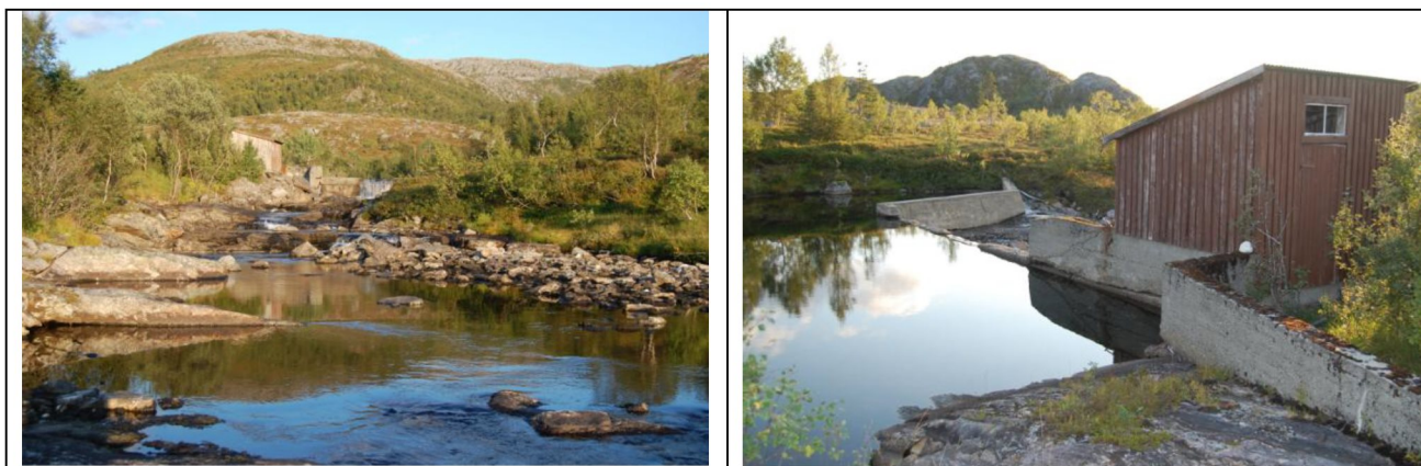
Bilde 9 og 10 viser partier fra midtre deler av fallstrekningen med inntak til eksisterende vannverk.
