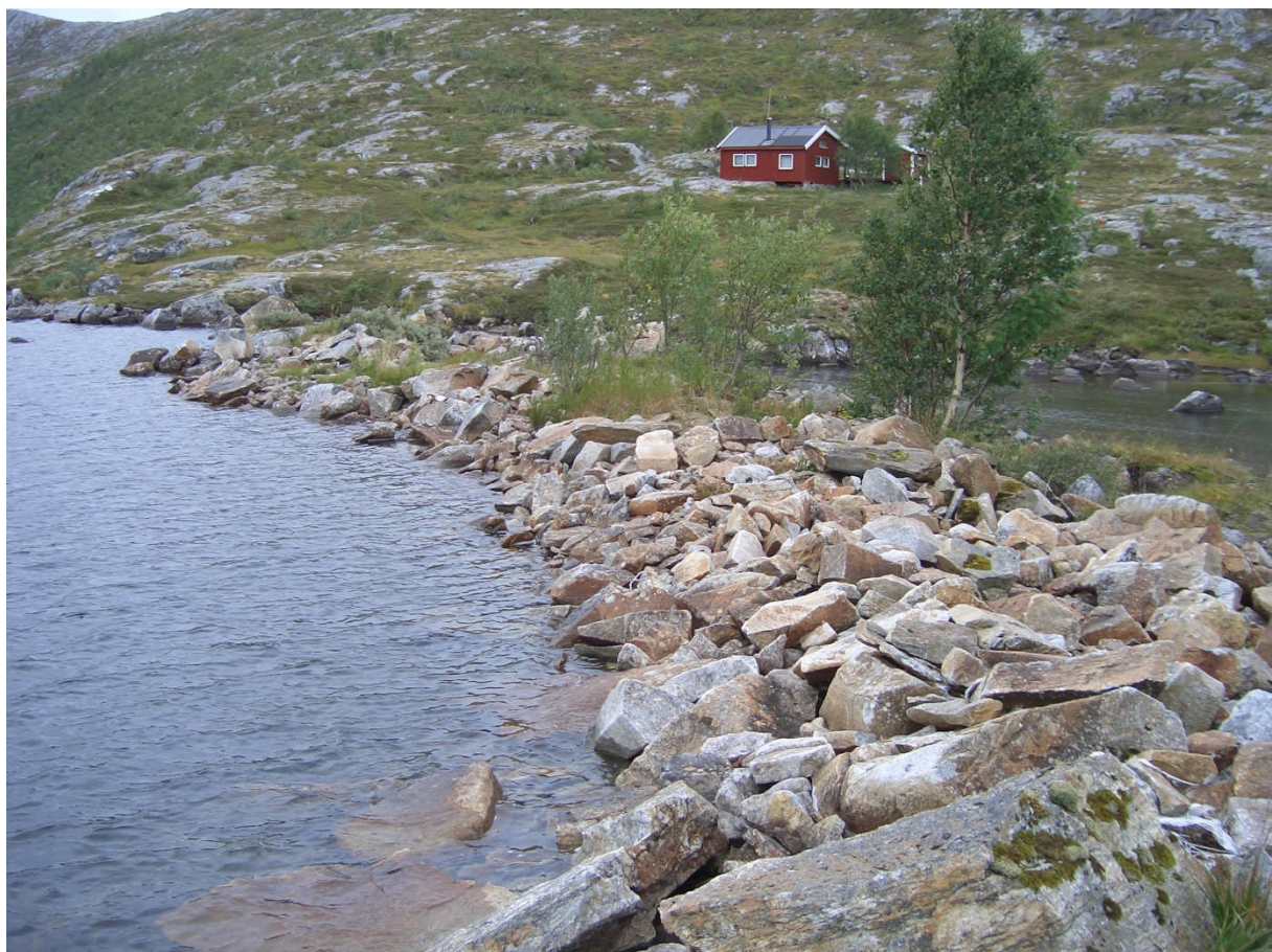
Figur 9: Bilde av eksisterende dam ved utløpet av Dagsvikvatnet.
