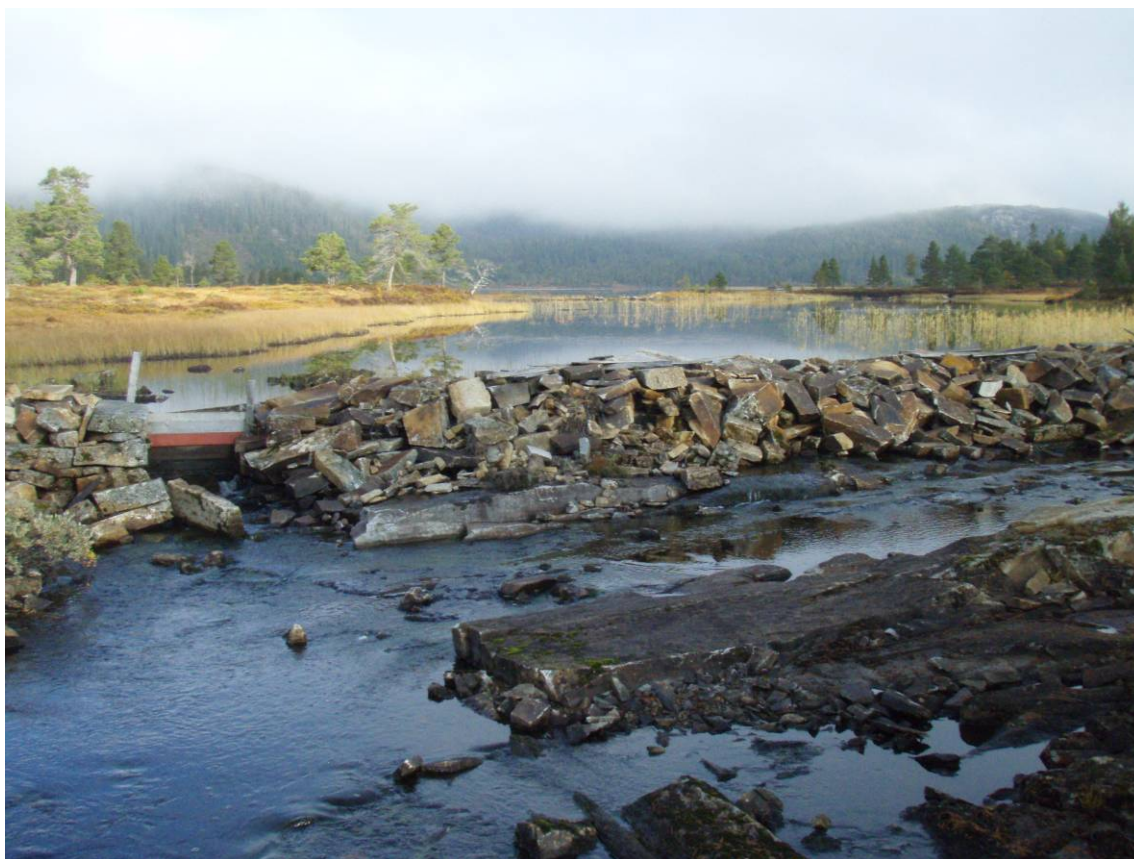
Nedstrøms eksisterende steinfyllingsdam ved Roksetvatnet
