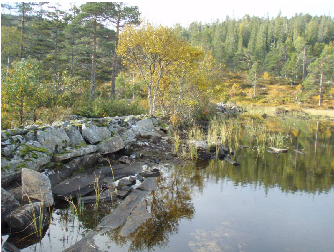
Oppstrøms eksisterende steinfyllingsdam ved Roksetvatnet
