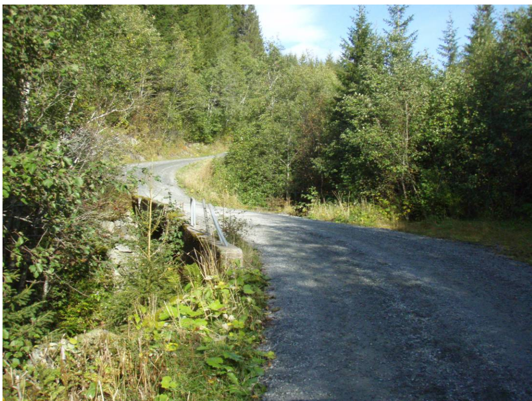
Eksisterende grusvei, bro over Dalabekken
