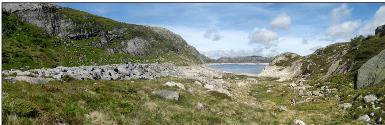
Figur 52 Steinfyllingsdammen og vika ved Håhellerdalen
