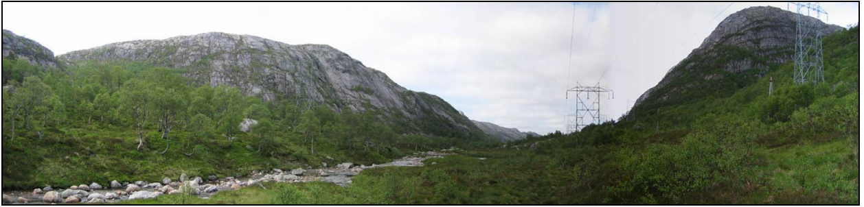
Figur 24 Sett mot nordøst. Fotoet viser tre høyspentlinjer som går sørøst for elva (til høyre i bildet) og én som går på nordvestsiden av elva.
