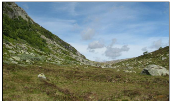
Figur 39 Øverst i Håhellerdalen. Steinfyllingsdam ved Lyngsvatnet midt i bildet.
