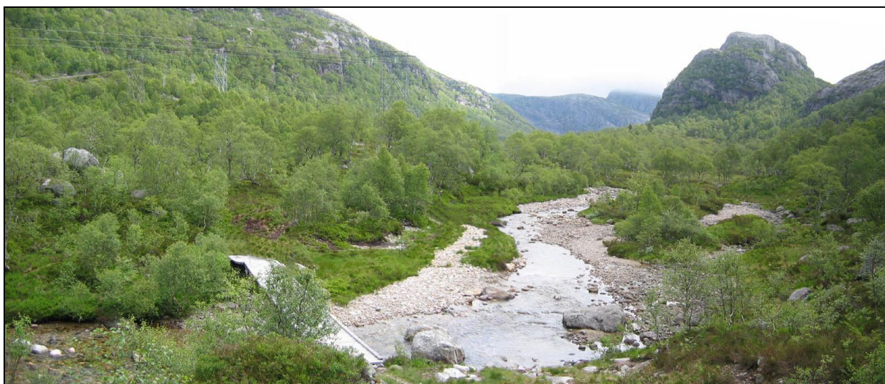
Figur 23 Brukryssing ved elvedelta. Sett mot nordøst.
