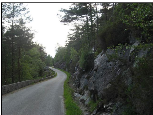
Figur 15 Vei i bratt fjellside.
