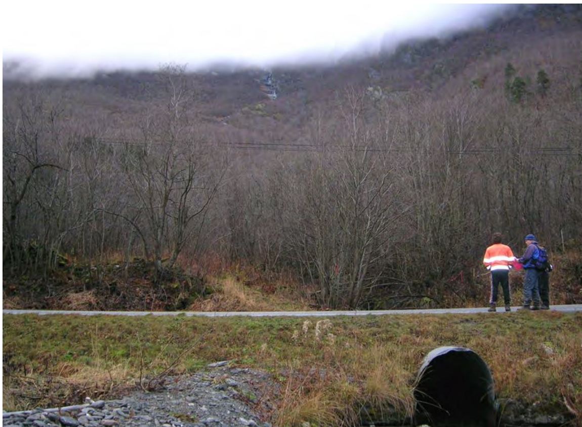
Foto 12 Kulvert under riksvegen like nedstrøms kraftstasjonsutløp. Kraftstasjonstomt til venstre i bildet og Gryta og foreslått rørtrasé i bakgrunnen
