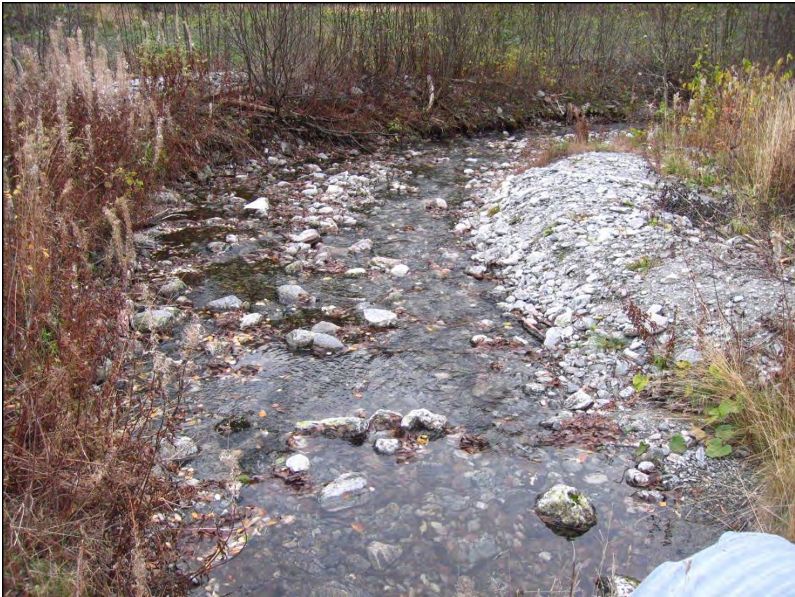
Figur 12: Gryta nedstrøms kulverten under rv. 70. Bildet er tatt i oktober 2007.
