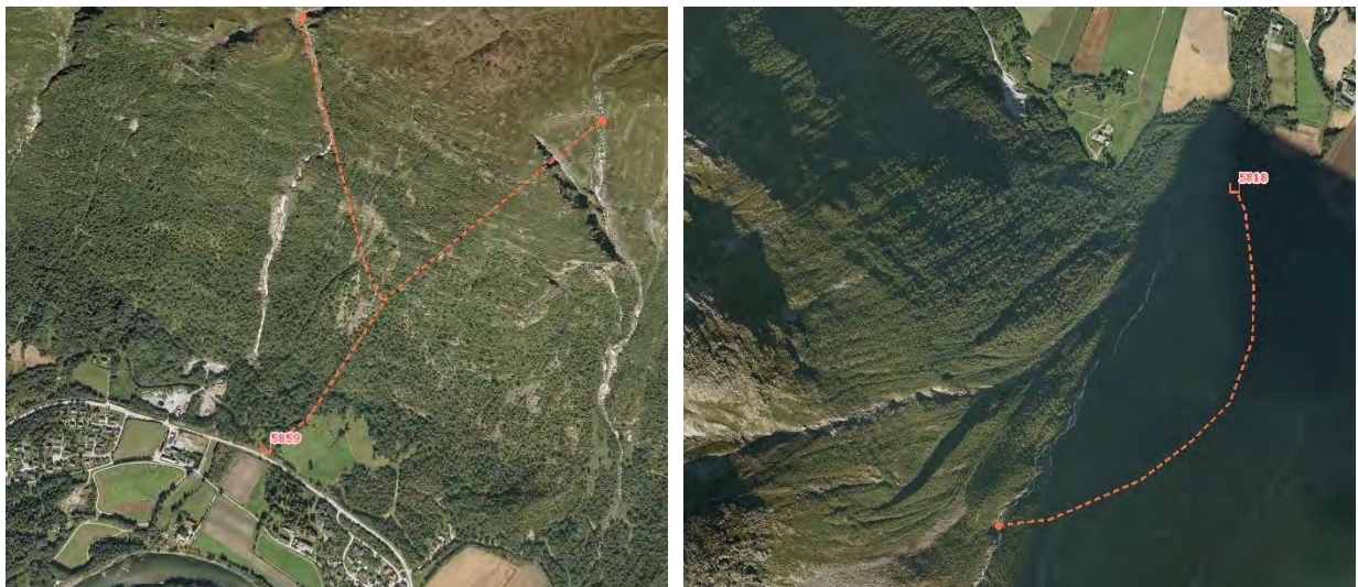
Figur 23. Torske (t.v.) og Hareima (t.h.) kraftverk. Kilde: NVE Atlas.
