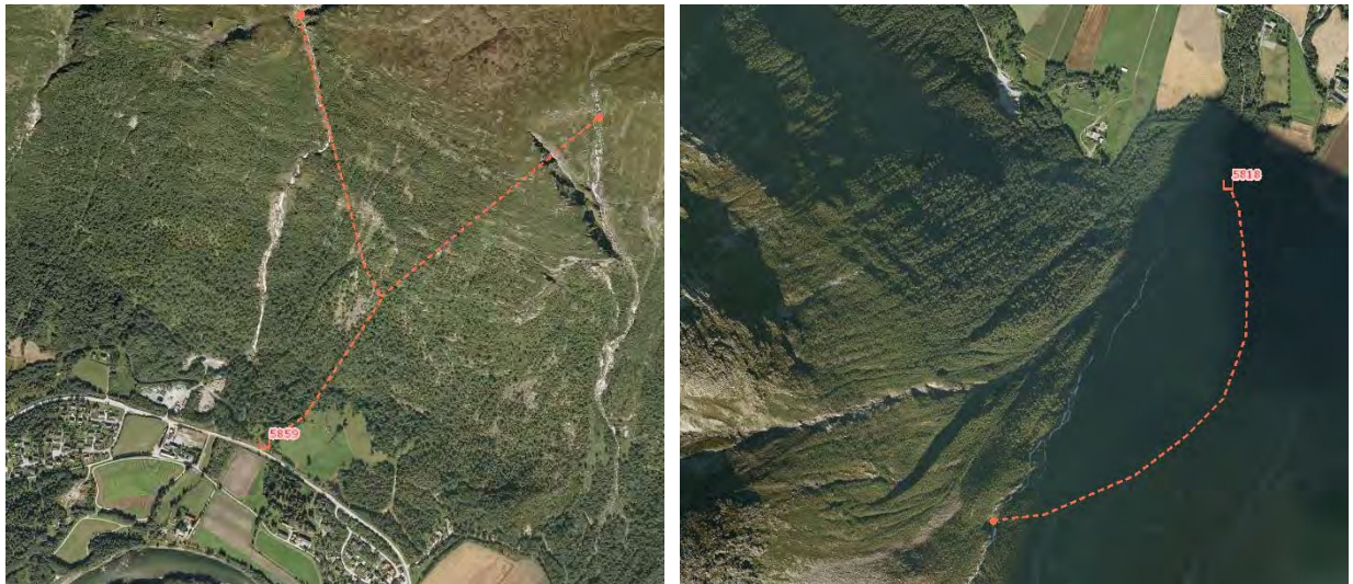
Figur 15. Torske (t.v.) og Hareima (t.h.) kraftverk. Kilde: NVE Atlas.
