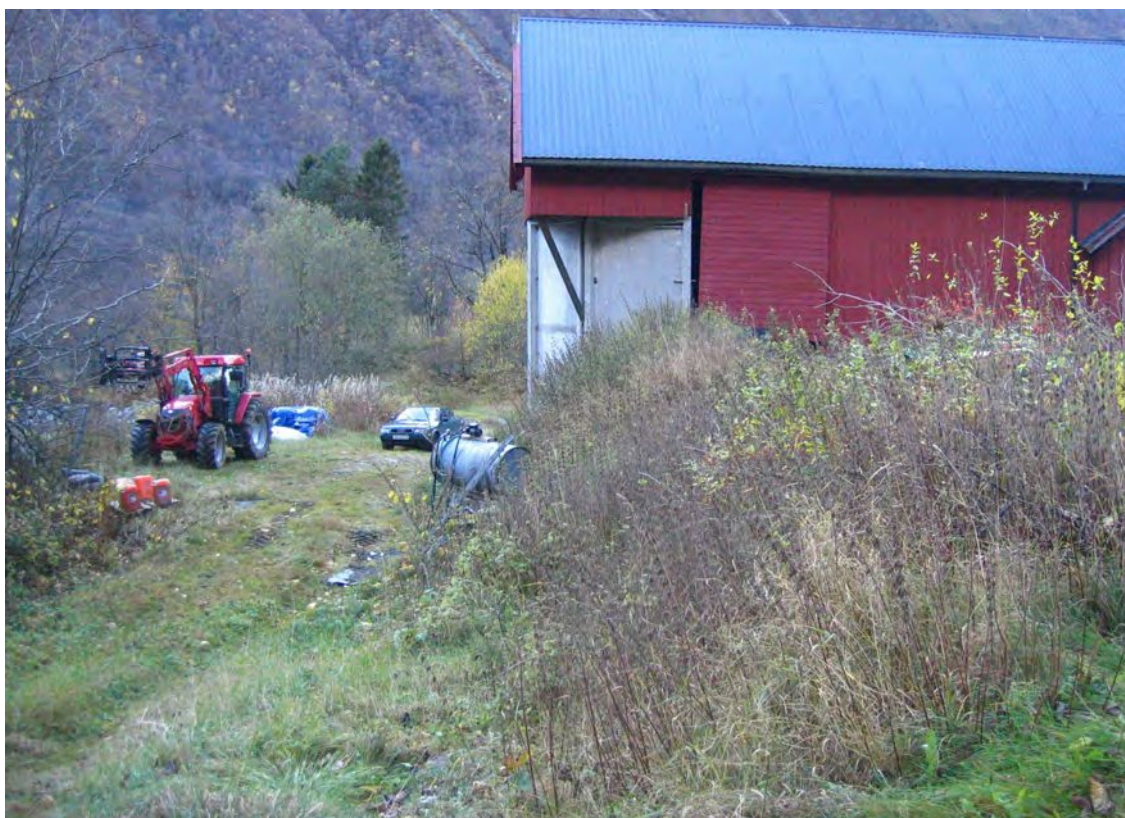
Foto 9 Adkomstveg til kraftverket følger traktorveg til venstre i bildet.
