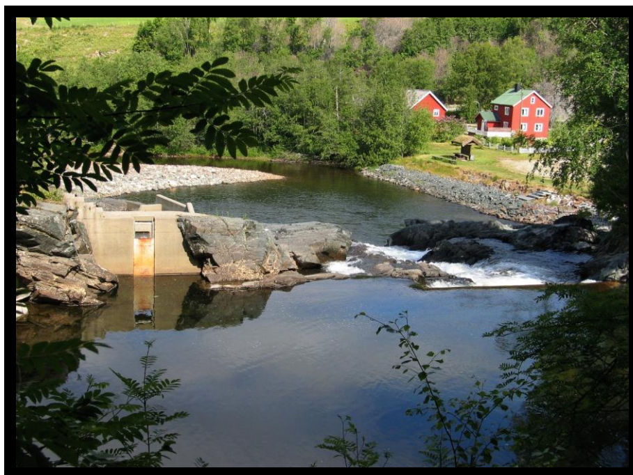
Kleivfossen – fossenakken med fisketrapp og vannspeil
