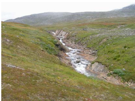
Bilde 2.11 Elva sett nedenfra ca kote 740
