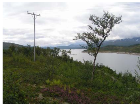
Bilde 5.2 Nærmeste 22 kV stolpe på østsiden
