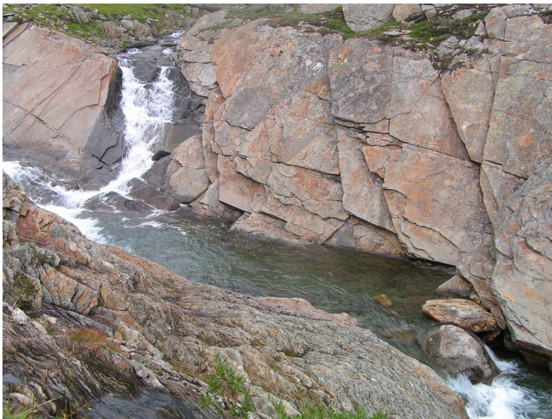
Bilde 1.1 Inntak – ca kote 755 moh
