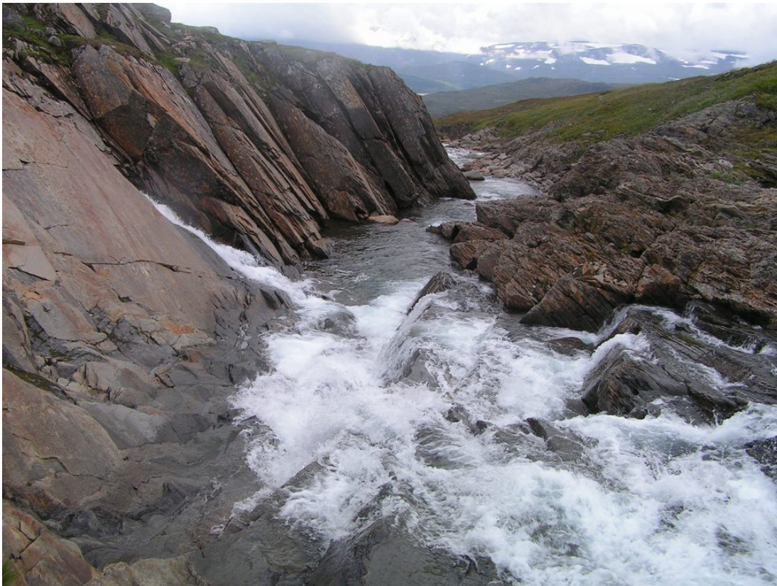
Bilde 1.3 Inntak ca kote 755 moh - sett ovenfra
