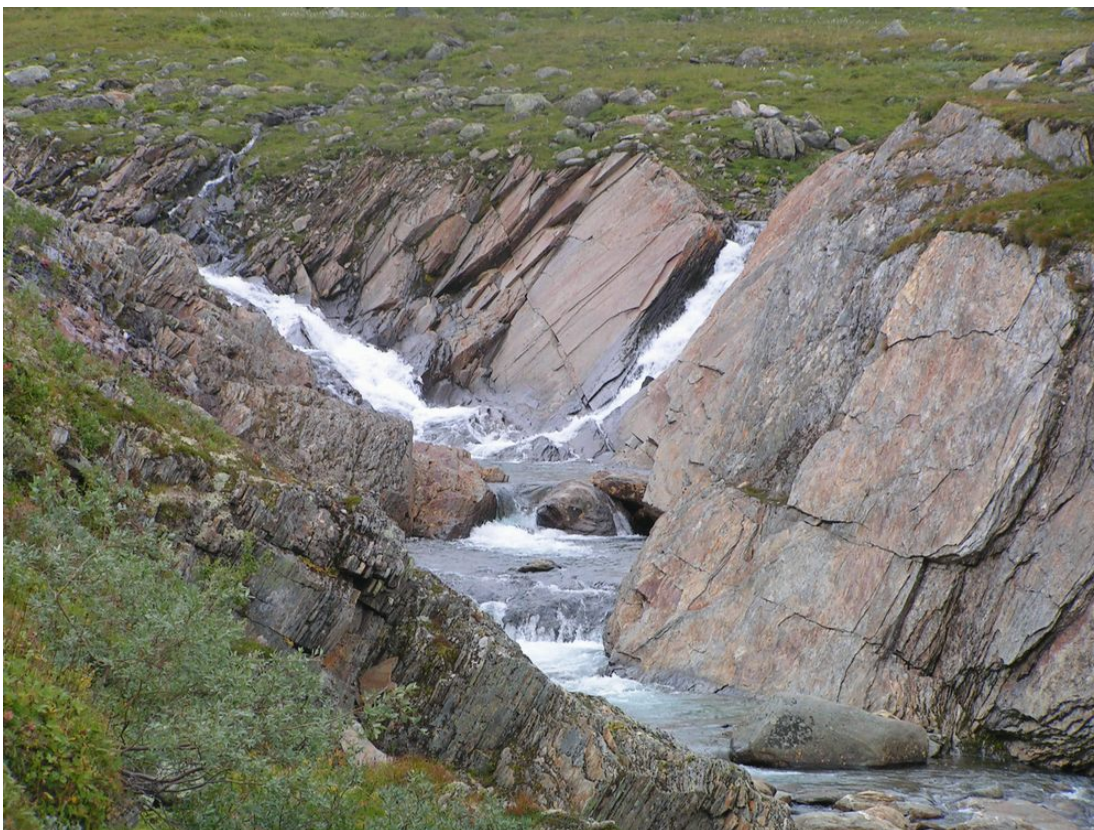
Bilde 1.4 Inntak ca kote 755 moh - sett nedenfra
