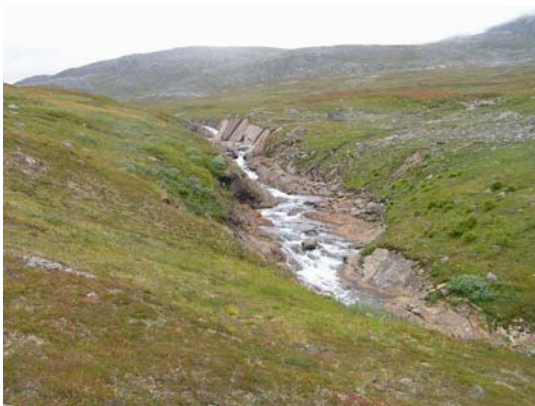
Bilde 2.11 Elva sett nedenfra ca kote 740
