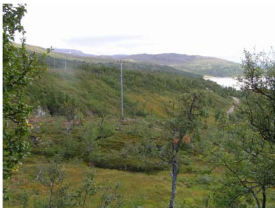
Bilde 5.1 Eksisterende 22 kV nett sett østover – vegen ses til høyre
