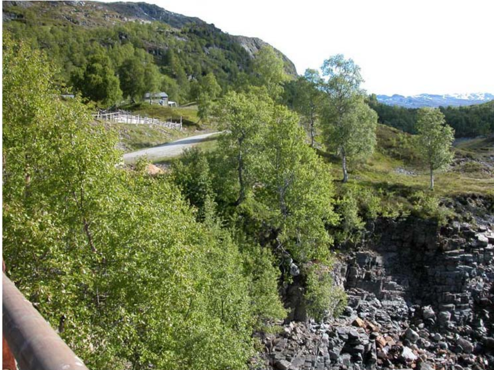
Bilde 1. Kraftstasjonen er planlagt på nedsiden av veien inn Valldalen, helt til høyre i bildekanten. Ved HRV i Valldalsvatnet går vannspeilet inn under brua bildet er tatt fra. Rørgata vil krysse veien til høyre for den synlige veistrekningen og fortsette oppover mot inntaket bak stølshuset som kan sees i bakgrunnen.
