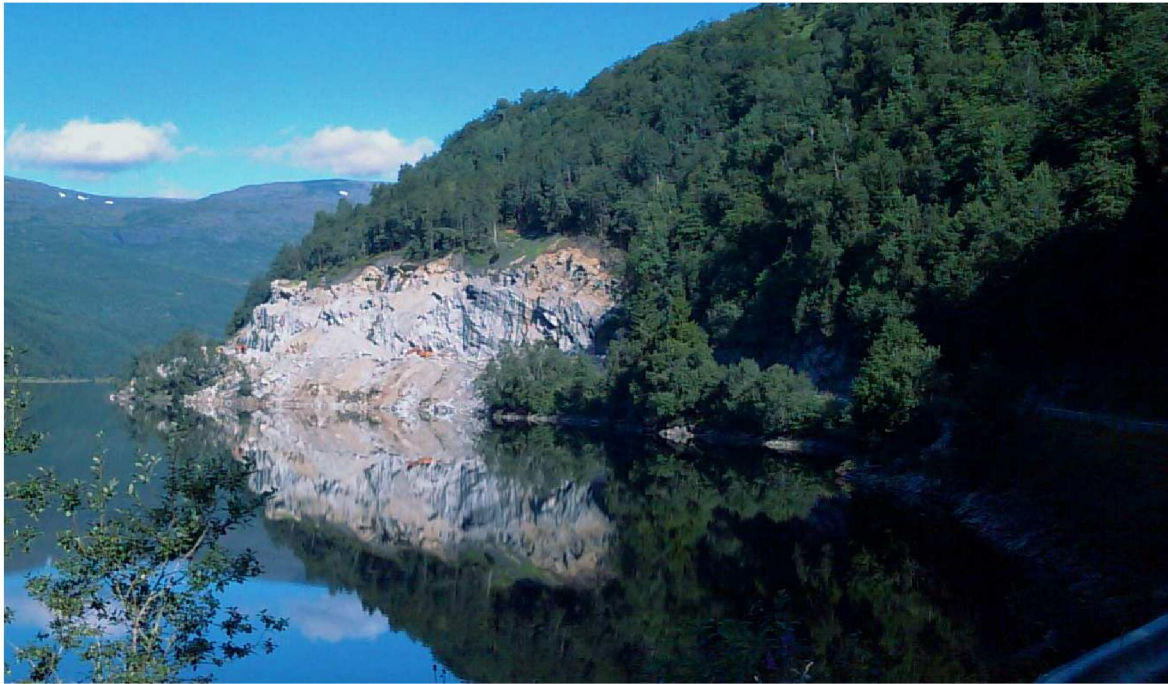
Figur 3: Døme på vegutbetring av Myrkdalsvegen, utbetringa av gamle vegen til venstre på bildet viser godt att i landskapet, tunnel i høgre parti av bildet.
