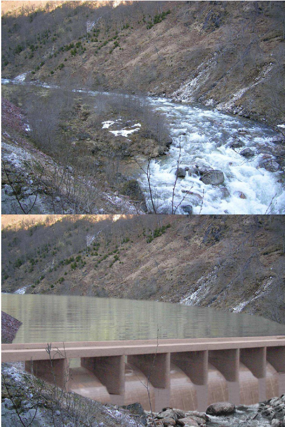
Figur 6: Planlagt inntak (før og etter situasjon) Dammen er planlagt med køyrebane over dammen. Bildet er teke på utkøyringa like etter den øvste tunnelen. Fotoillustrasjon er henta frå Landskapsrapporten
