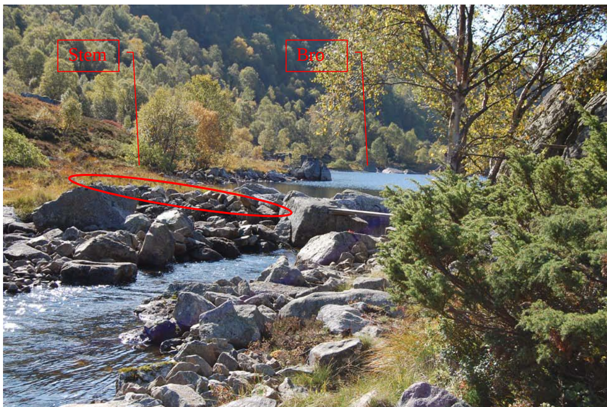
FIGUR 9: OVERSIKT OVER UTLØPET FRA DJUPAVATNET. DEN GAMLE STEMMEN KAN SEES TIL VENSTRE I BILDET. TIL HØYRE ER BROA OVER UTLØPET. LUKEHUSET VIL BLI Plassert omtrent der broa er.
