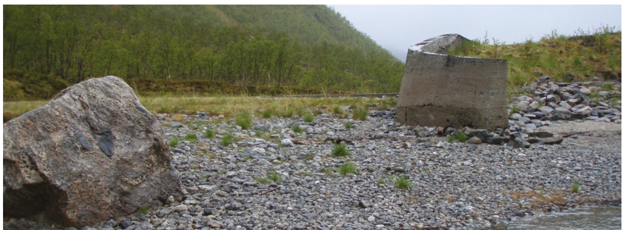
Bilde 7 Overløpet og overløpsvange sett fra Bleksvatnet
