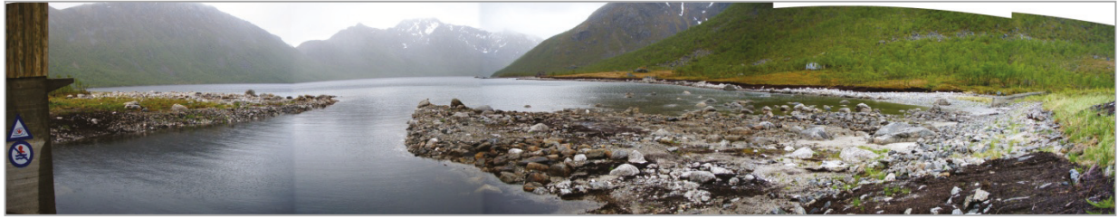
Bilde 5 Utsyn over Bleksvatnet fra inntaket til Lovik kraftverk
