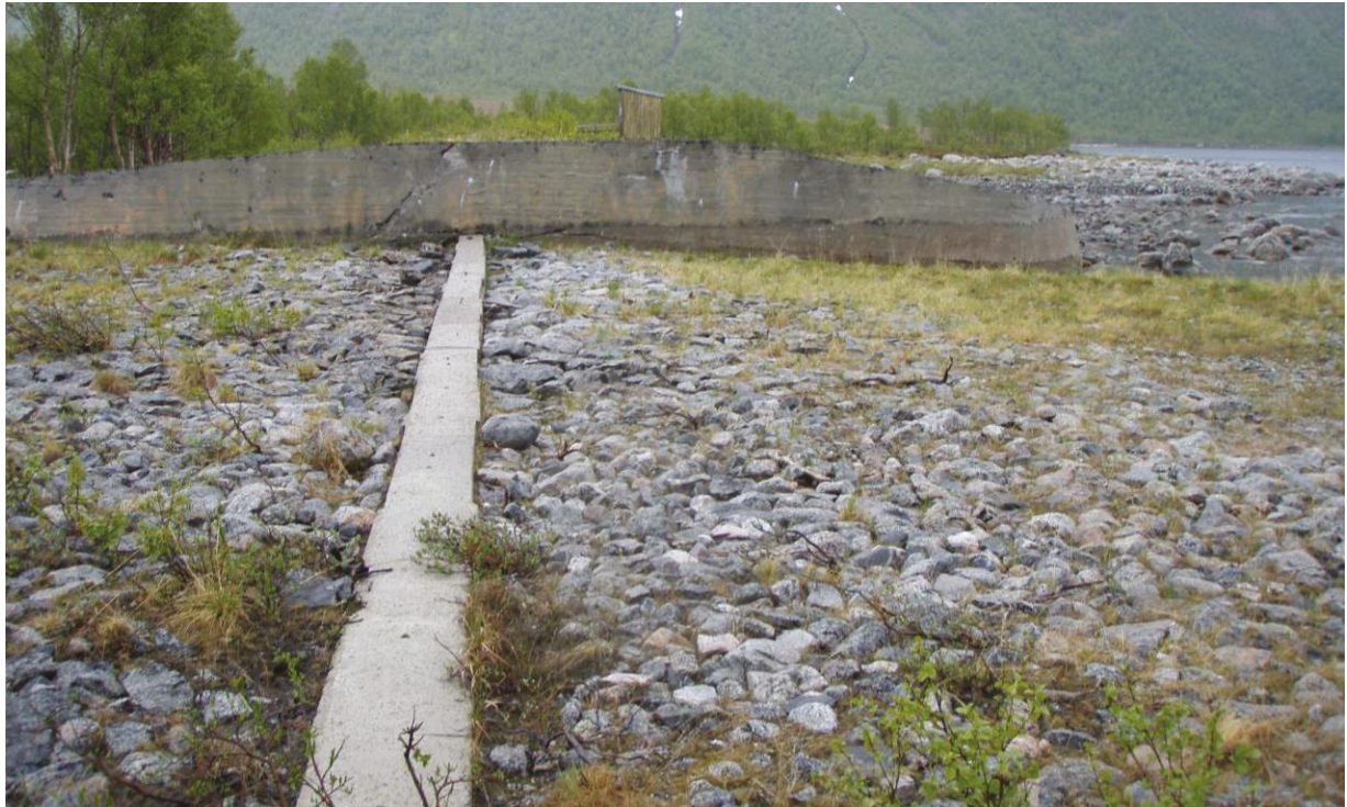
Bilde 8 Overløpet på dam Bleksvatnet
