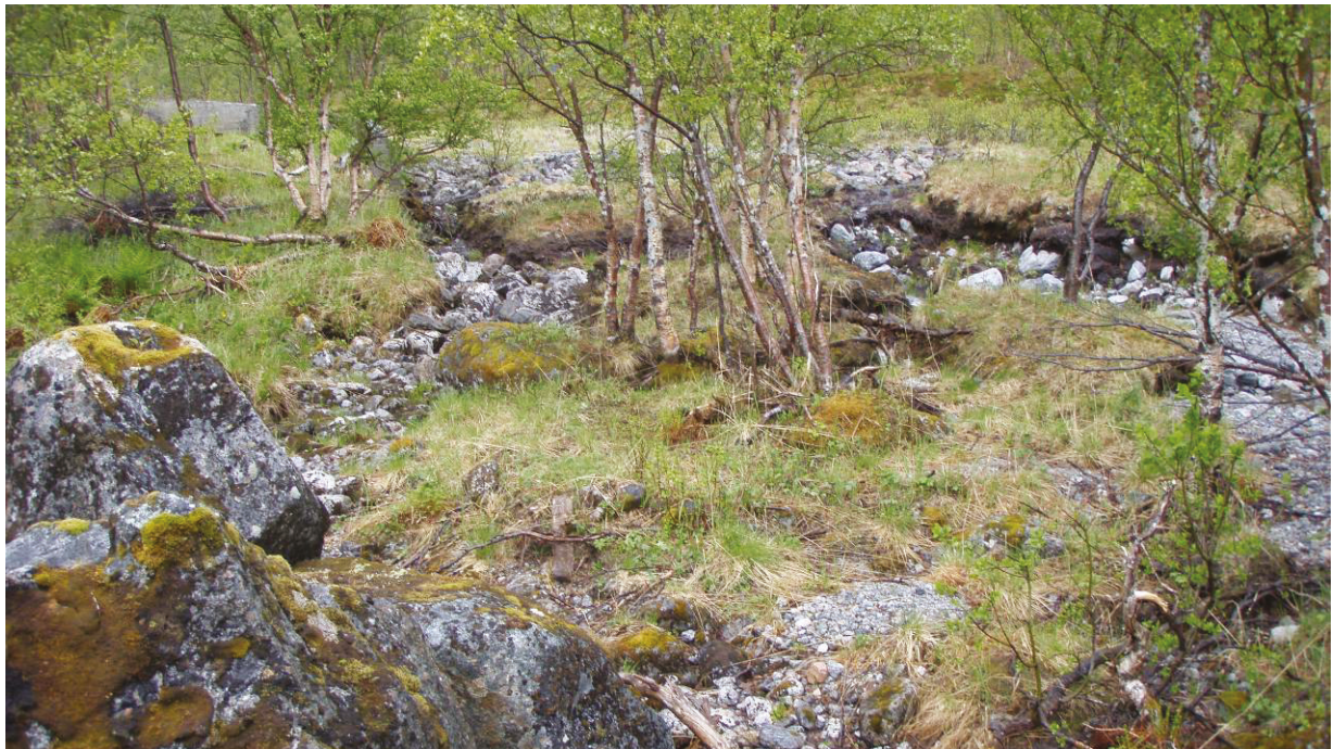
Bilde 9 Storelva nedstrøms overløpet til dam Bleksvatnet. Overløpsdammen vises øverst til venstre. Sett motstrøms.
