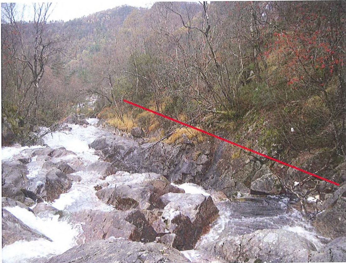
Bilde 7: Øvre deler av rørtrase, til høyre for bekken.
