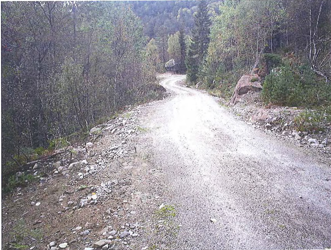
Bilde 14: Område hvor rørgaten kommet ut på atkomstvei.
