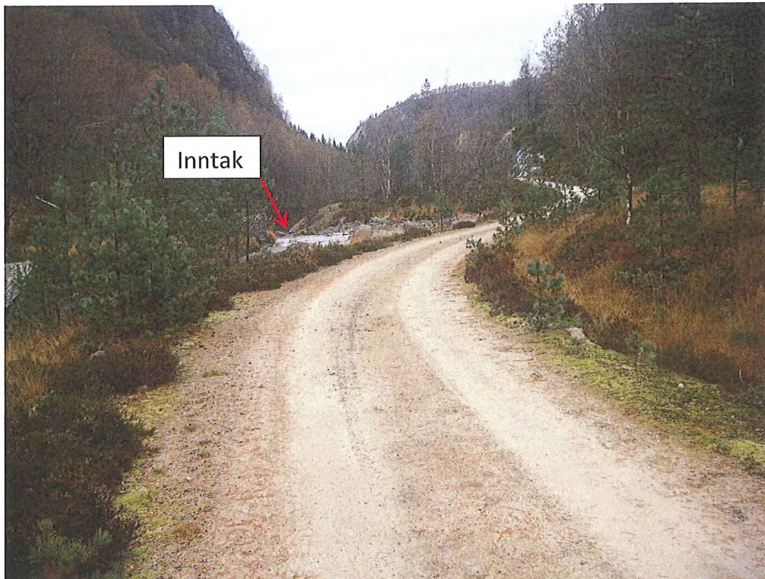
Bilde 1: Sett nedover mot inntak. Vei må heves.
