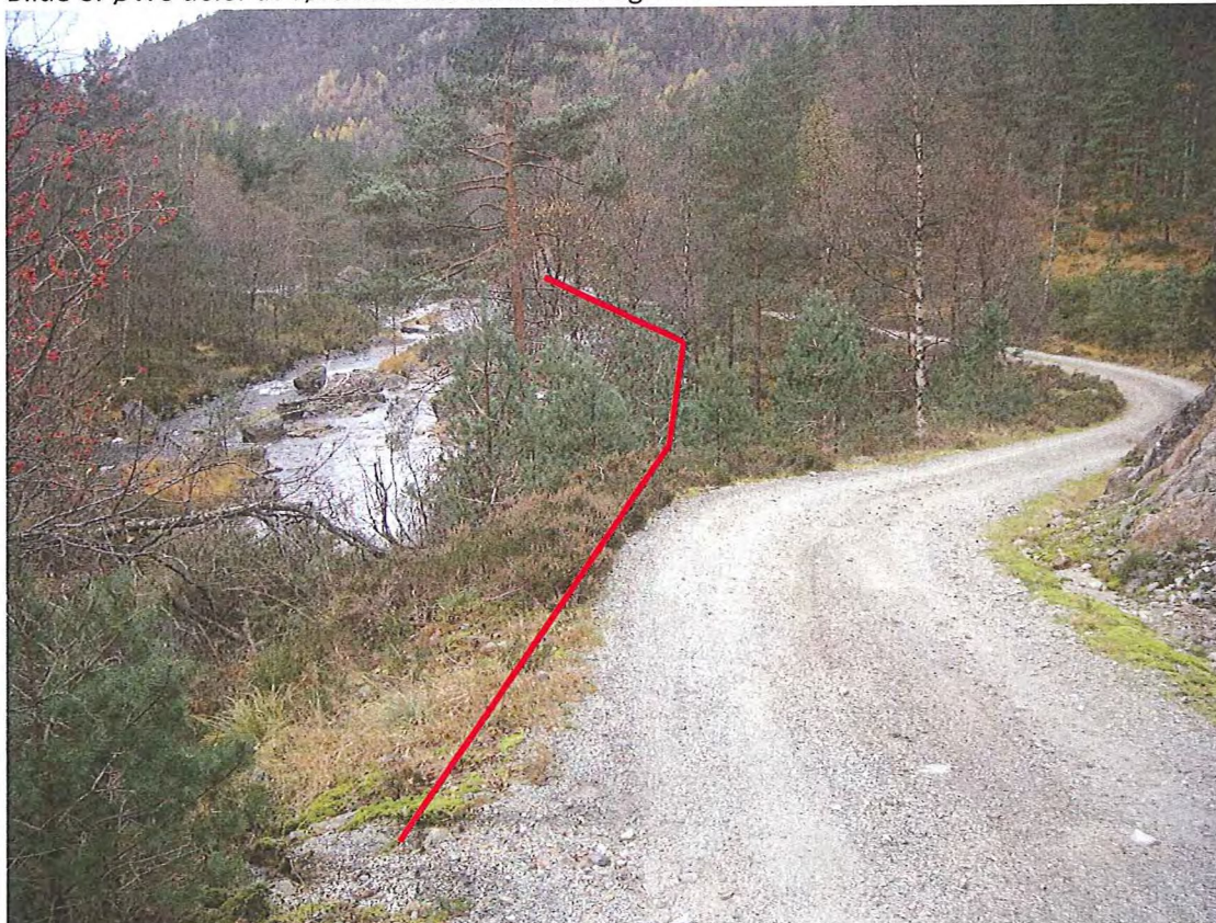
Bilde 9: Øvre del av rørtrase, sett nedover.
